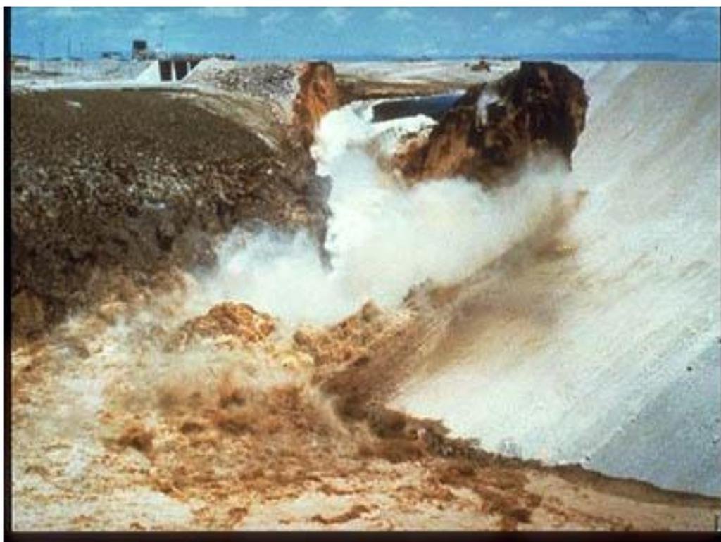
Figura 2: imagem da Barragem de Teton, no instante da ruptura
