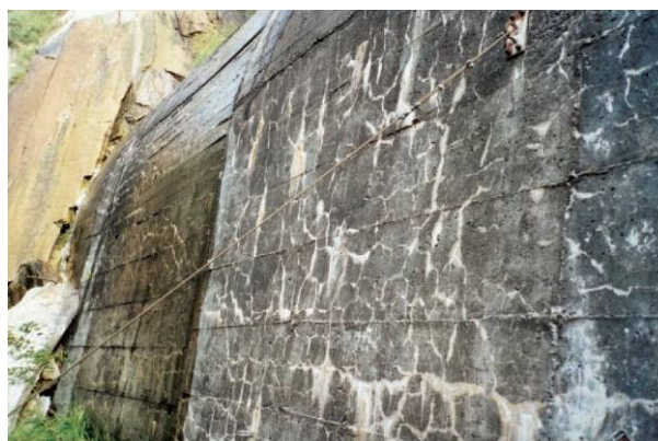
Figura 15: exsudação de gel (THALMANN et al., 2001, p. 22)
