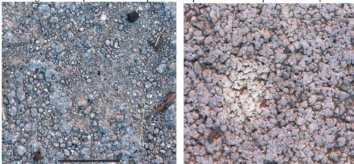
Figura 14 - Aspecto da faixa 5 próxima ao ponto 10 antes e após a manutenção
