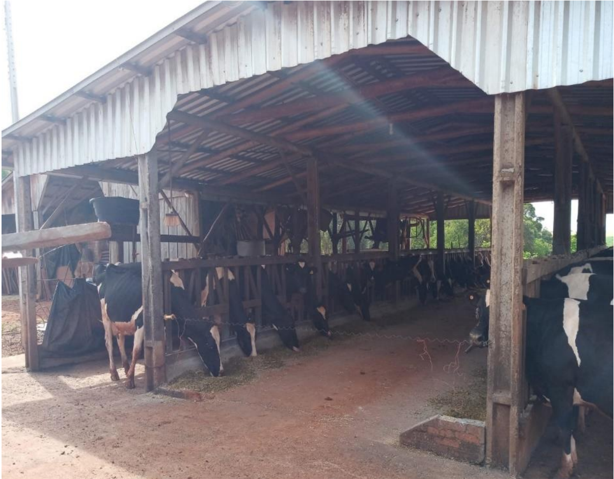
Figura 8 – Galpão Pós Ordenha/ Alimentação
