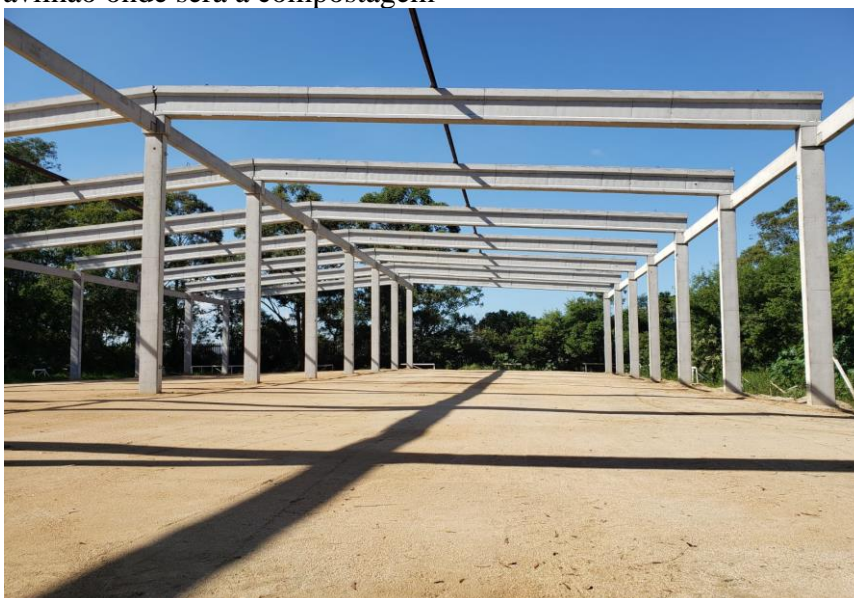
Figura 47 – Pavilhão onde será a compostagem
