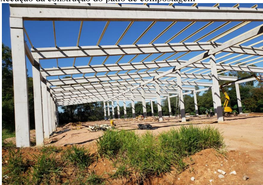
Figura 46 – Execução da construção do pátio de compostagem
