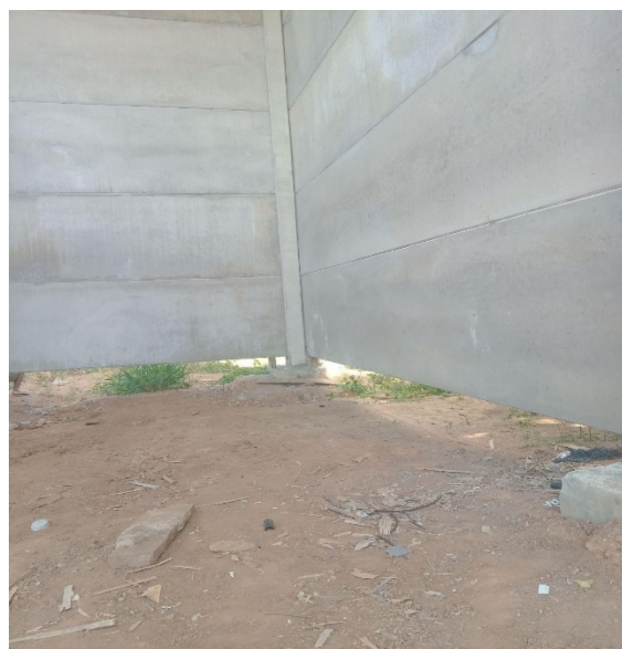
Figura 8: Galpão entregue sem piso (arquivo pessoal)
