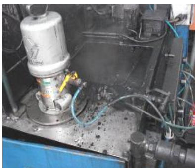
a) Tanque de lubrificante
