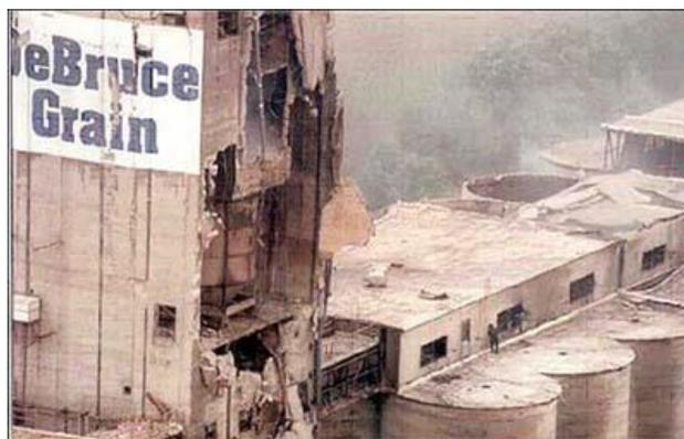
Figura 2 – Explosão do Elevador de caçambas DeBruce Grain. (OSHA,1998)
