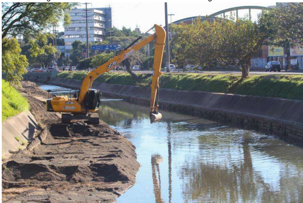
Figura 12: Desassoreamento do Dilúvio com Dragas da Prefeitura
