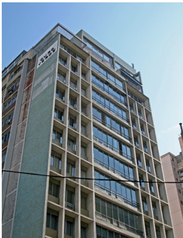
Figura 88: Fotografia do Edifício Ouro Verde (2008). Fonte: VIEIRA, comunicação pessoal, 2021.
