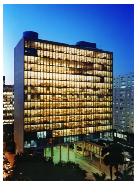
Figura 2: Fotografia do Edifício do Ministério da Educação e Saúde Pública. Fonte: VITRUVIUS, 2014. 2
