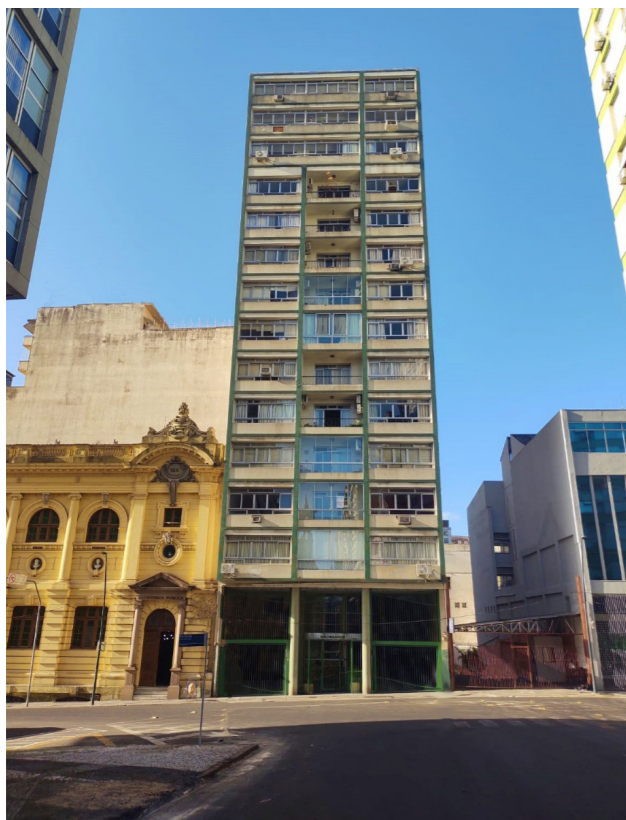
Figura 72: Fotografia Edifício Excelsior. Fonte: Elaborado pela autora, 2021.
