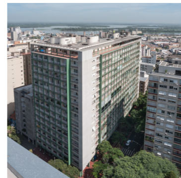
Figura 12: Edifício Esplanada. Fonte: ARCHDAILY, 2022. 5
