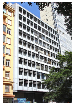
Figura 11: Edifício Santa Terezinha. Fonte: ARCHDAILY, 2022. 5
