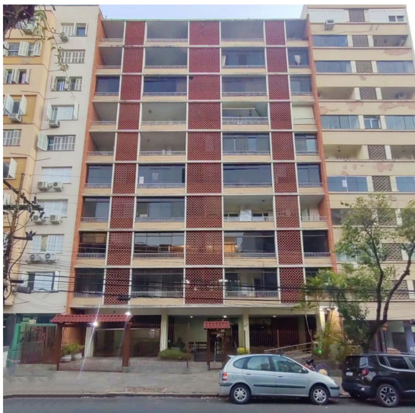
Figura 99: Fotografia Edifício Tapejara. Fonte: Elaborado pela autora, 2021.
