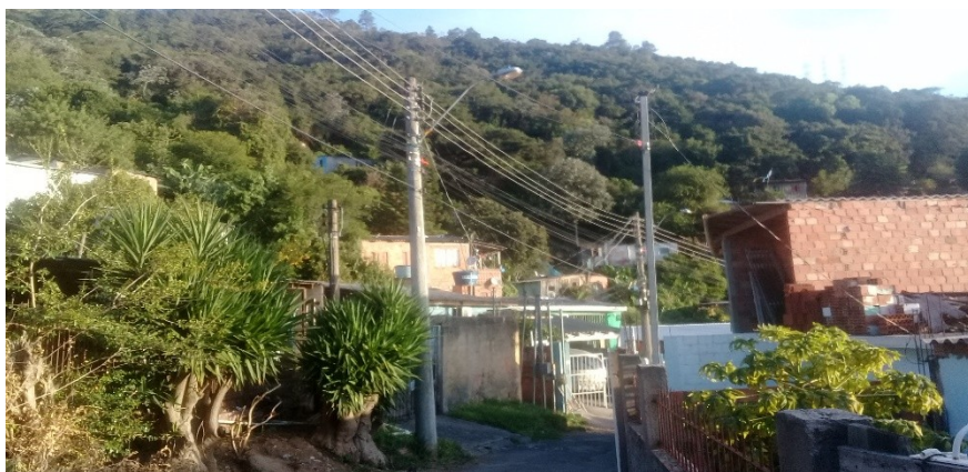
Figura 8 – Vista Rua 3, da Vila Laranjeiras – Construções irregulares em área de encosta de morro. Vista Noroeste do Morro Santana. Autor: Cristiano Fagundes Jardim. Ano:2023
