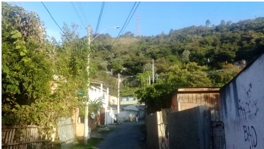
Figura 7 – Vista Rua 3, da Vila Laranjeiras – Construções irregulares em área de encosta de morro.Vista Noroeste do Morro Santana. Autor: Cristiano Fagundes Jardim. Ano:2023
