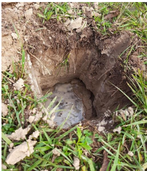
Figura 26. Abertura de trincheira de 30x48 cm onde é possível observar o nível freático em sua base.
