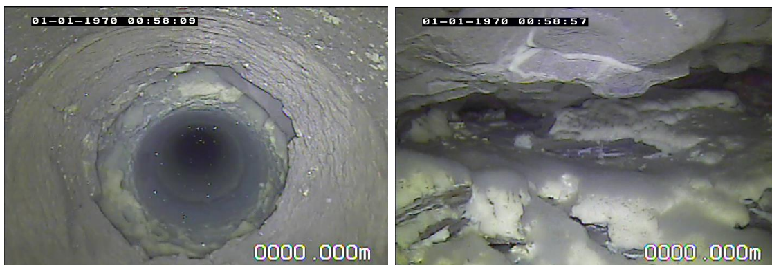
Figura 18. Zona de contato no poço TAR-12 entre o basalto e o arenito, à esquerda detalhe para as amígdalas onde há transição para o arenito, até a entrada d'água observada à direita onde ocorre o contato, ocorrendo precipitação de prováveis carbonatos.
