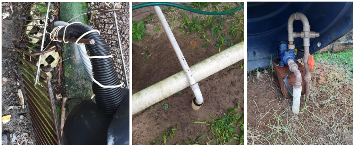
Figura 29. Poços ponteira TRP-05, TRP-06 e TRP-17 respectivamente, como diferentes formas de captação.
