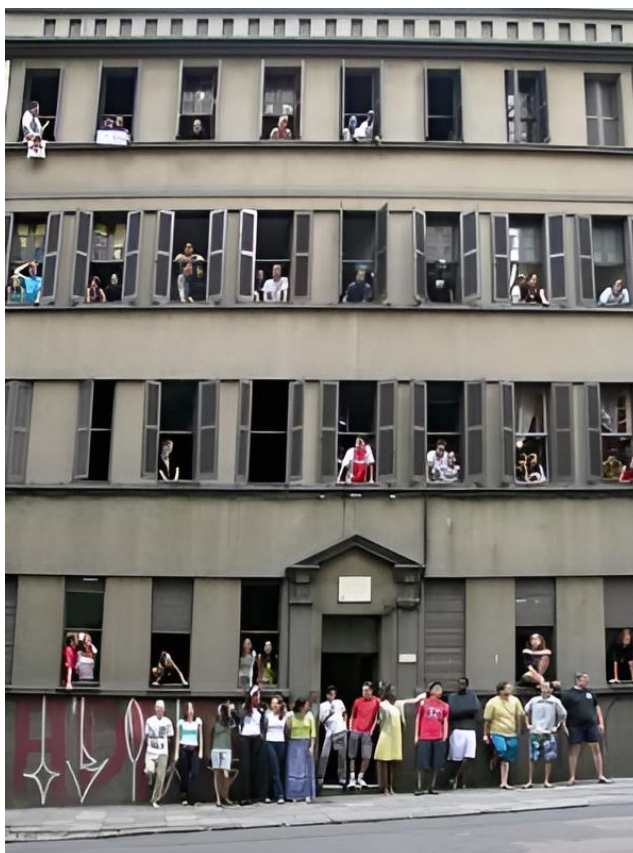
Imagem 30: Vista frontal da Ceuaca com o quarto pavimento (2005).
