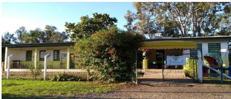
Figura 1: Escola Municipal de Ensino Fundamental Álvaro Almeida.
