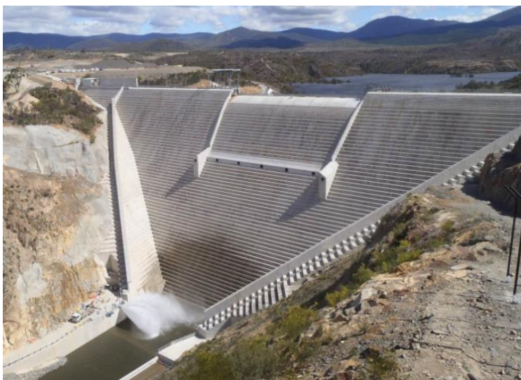
a) Vista diagonal do vertedouro
