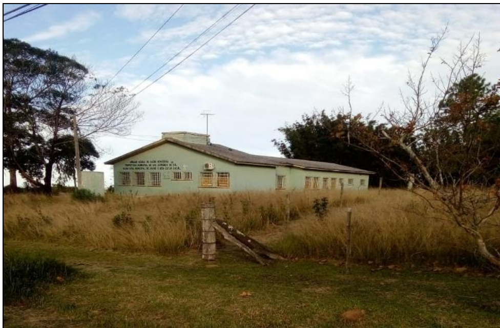
Figura 6 – UBS da Comunidade de Boqueirão, que atende a região e seus entornos
