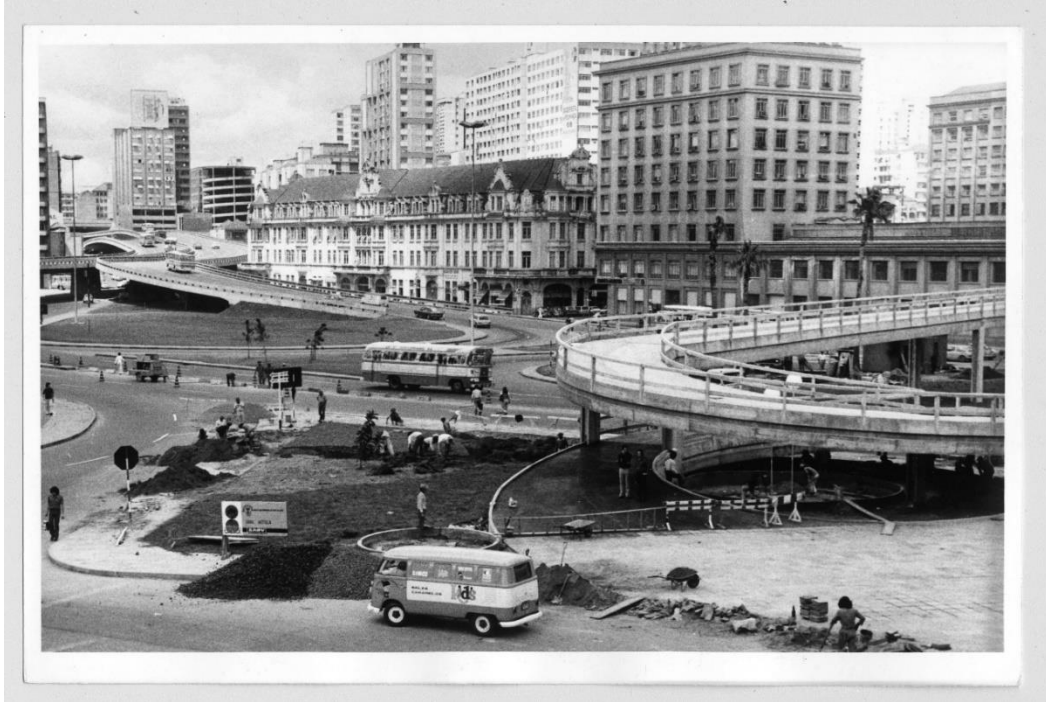
Figura 22: Construção da passarela da rodoviária (09/11/1974). Fonte: Acervo Museu de Porto Alegre Joaquim Felizardo.
