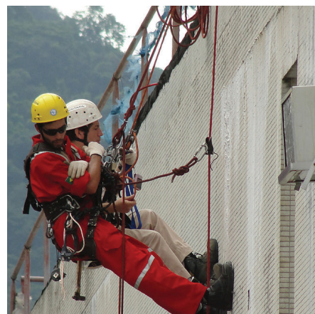
03.98 - Jorge Astorga realizando inspeção das condições da fachada. Fonte: Astorga Arquitetura e Restauração.
