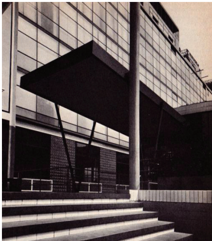
I.31 - Cite Refuge, Le Corbusier. Detalhe de marquise inclinada apoia em pilar "V". Fonte: BOESINGER, 1971.
