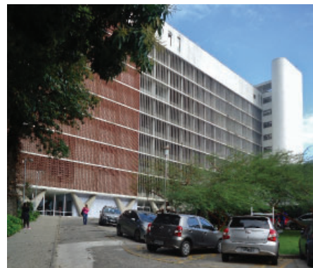
03.34 - Fachada Noroeste, detalhes da torre de circulação vertical, brises de alumínio e cobogós. Foto: Luis Henrique Haas Luccas.
