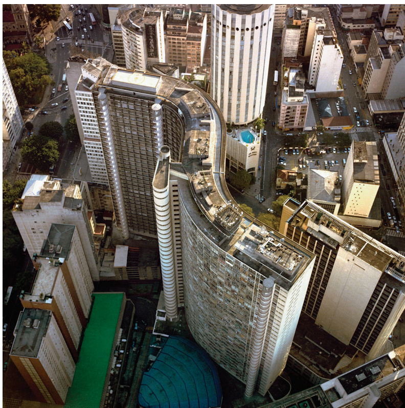
03.35 - Imagem aérea do Copan, destacando a torre de circulação vertical. Foto: Nelson Kon
