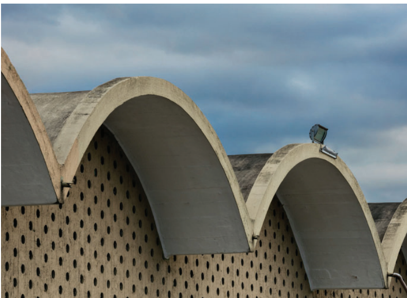
03.94 - Clube dos 500, detalhe das abóbadas. Foto: Nelson Kon
