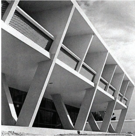
03.59 - Pilotis em V do Hotel Tijuco em Diamantina. Fonte: Fundação Oscar Niemeyer.
