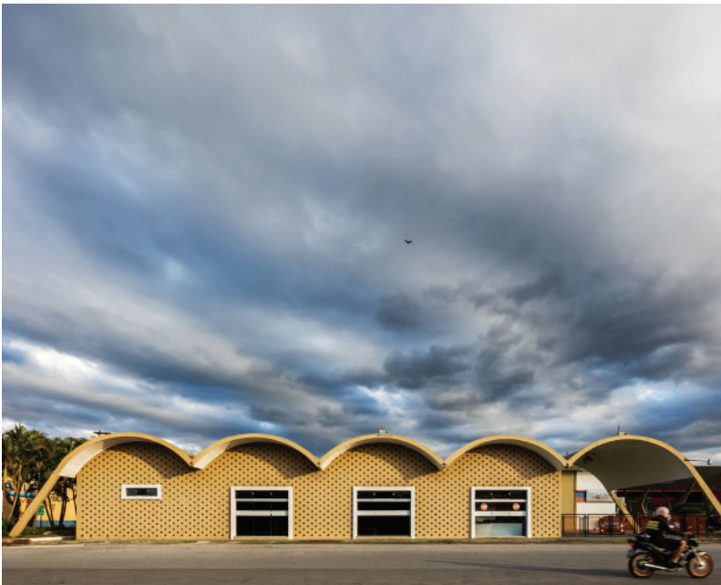
03.93 - Clube dos 500, solução de abóbadas e apoio similar ao caso da Biblioteca do CTA. Foto: Nelson Kon
