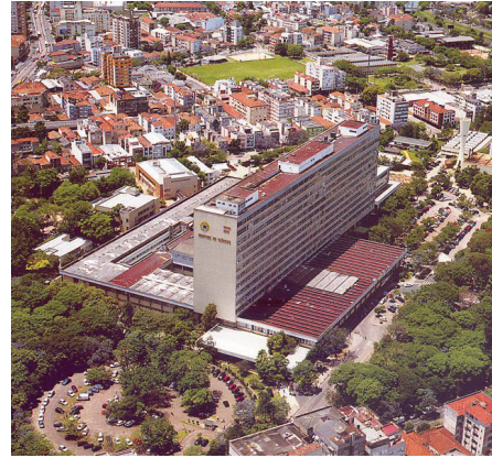
01.39 - Vista aérea do Hospital de Clínicas de Porto Alegre concluído. Fonte: Arquivo HCPA;
