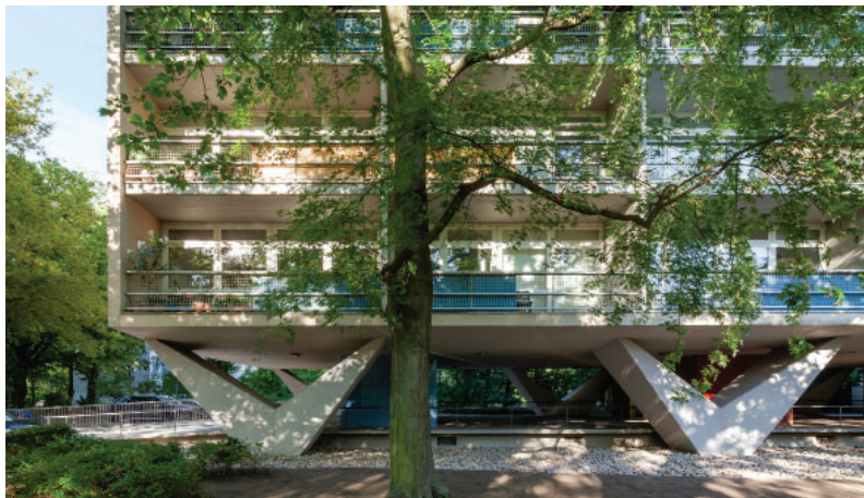
03.41 - Edifício de apartamento em Hansaviertel, base de serviços recuada em relação aos pilotis. Foto: Pedro Vannucchi.
