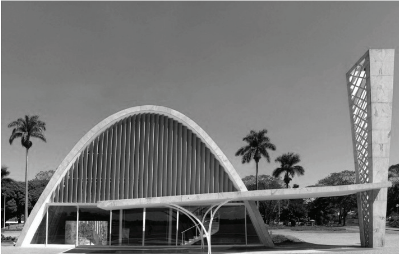
I.24 - Fachada frontal da Igreja São Francisco de Assis. Detalhe para pilares de sustentação da marquise. Foto: Victor Hugo Mori
