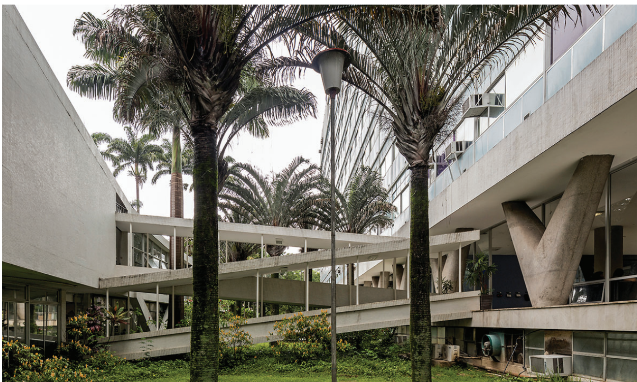
03.43 - Rampas de ligação entre a lâmina e o volume anexo, vistas do jardim. Foto: Leonardo Finotti.
