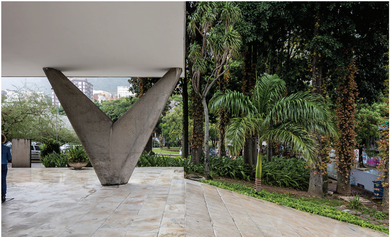
I.44 - Hospital da Lagoa. Foto: Leonardo Finotti
