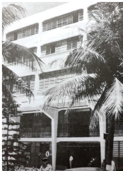
01.30 - Fachada do Hospital da Brigada, Recife. Projeto de Luis Nunes, em 1935. Fonte: BRUAND, 1981.
