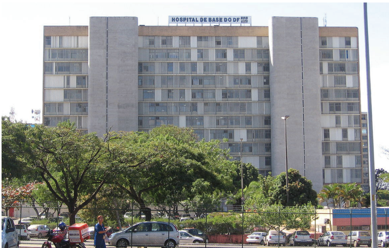
03.30 - Fachada sudoeste, tratamento com brises e torres de circulação vertical externas. Foto: Luis Dantas.
