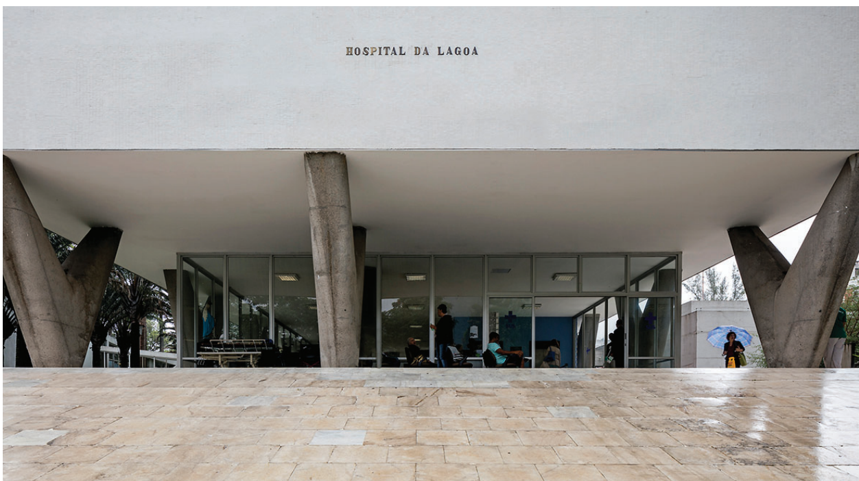
03.10 - Fachada Leste, contraste entre o volume anexo e a lâmina corbusiana. Foto: Leonardo Finotti.
