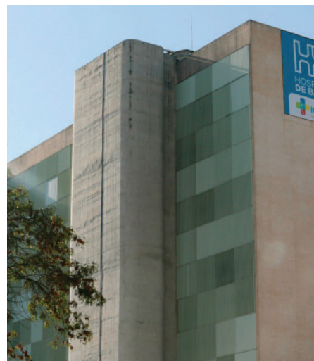
03.29 - Detalhe dos brises e do volume externo para circulação vertical, estratégia similar ao Hospital da Lagoa. Foto: Davidyson Damasceno
