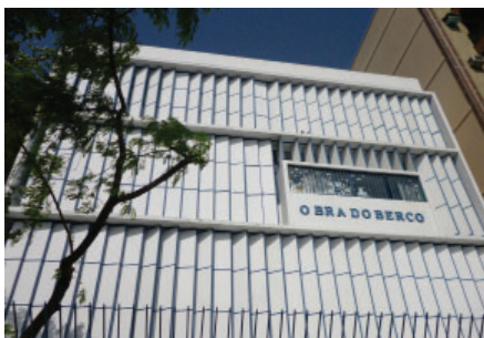
2.06 - Brises móveis fechados. Fonte: foto de Luca Bullaro
