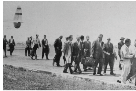
01.23 - Chegada dos congressista à Brasília ainda em obras. Fonte: ROSSETTI, 2009.
