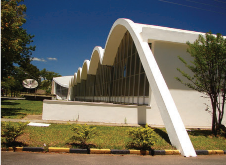
03.92 - Detalhe da apoio das abóbadas no projeto do Centro de Tecnologia da Aeronáutica. Fonte: Acervo ITA
