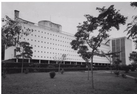
01.33 - Fachada do Instituto Vital Brazil. Fonte: Acervo Biblioteca IBGE;
