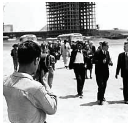
01.24 - Chegada dos congressistas ao Palácio do STF. Ao fundo, destaca-se as estruturas do congresso nacional em obras. Fonte: ROSSETTI, 2009
