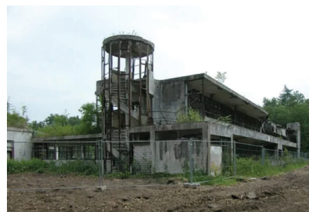
03.120 - Estado de abandono do Sanatório de Zonnestraal antes da reforma. Foto: Paul Meurs
