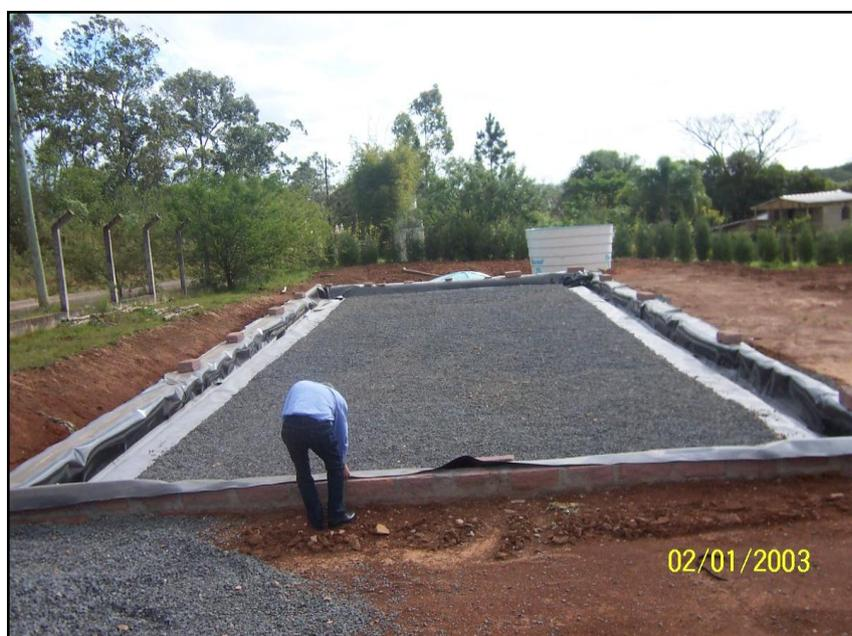
Figura 3.5: Preparação da célula na ETA, Gravataí-RS
