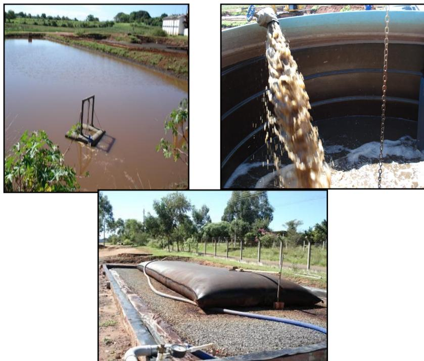
**Figura 1.1:** Foto da planta – etapa de bombeamento do tanque de equalização para a bolsa geossintética.
