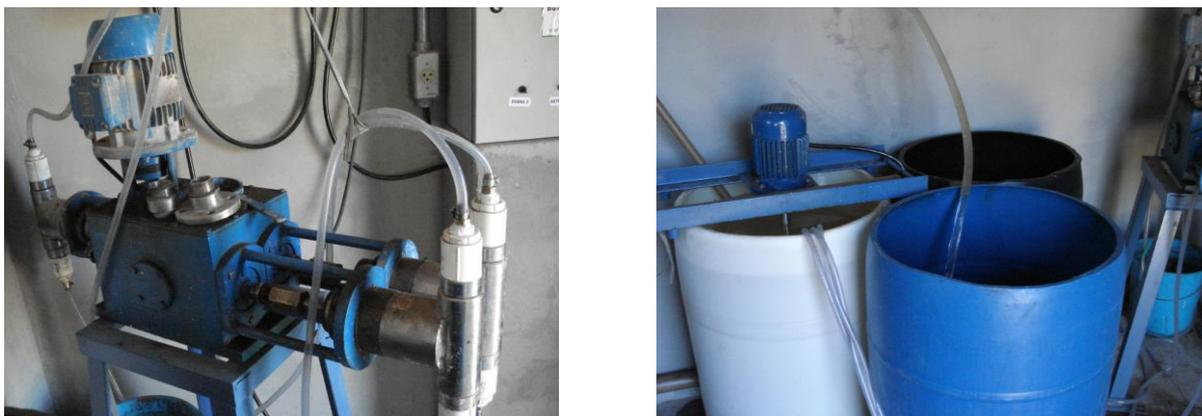
**Figura 5.1:** Bomba dosadora e tanques de preparação do polímero utilizada no teste na ETA de Gravataí - RS
