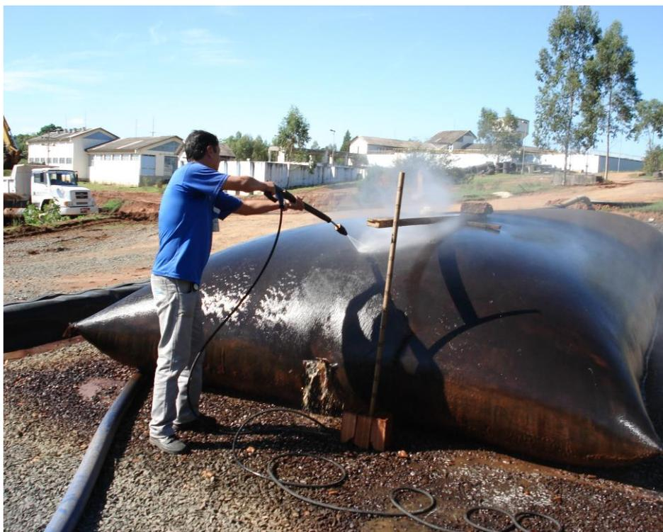
**Figura 5.18:** Medida operacional para remoção da colmatção.
