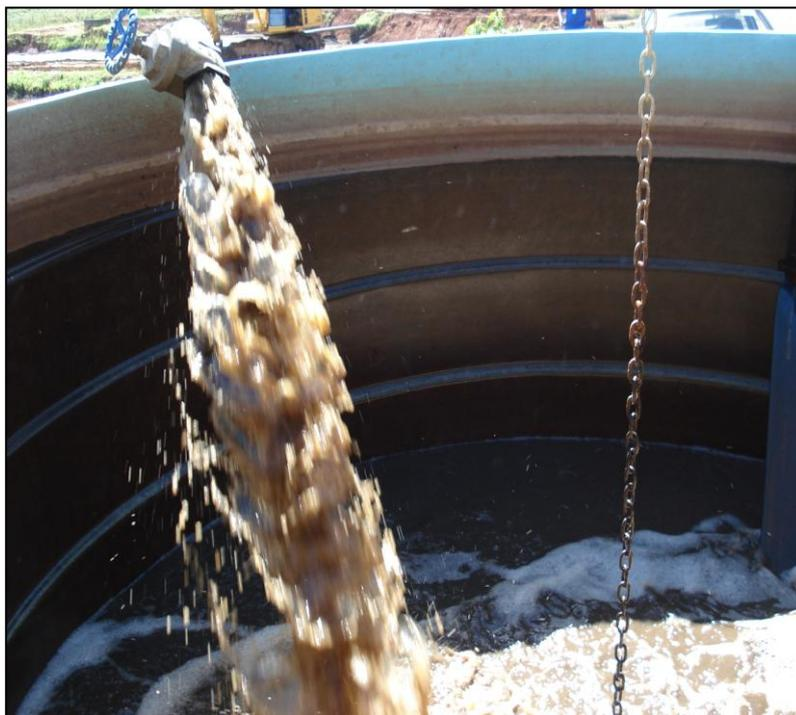
**Figura 3.6:** Tanque de equalização do lodo
