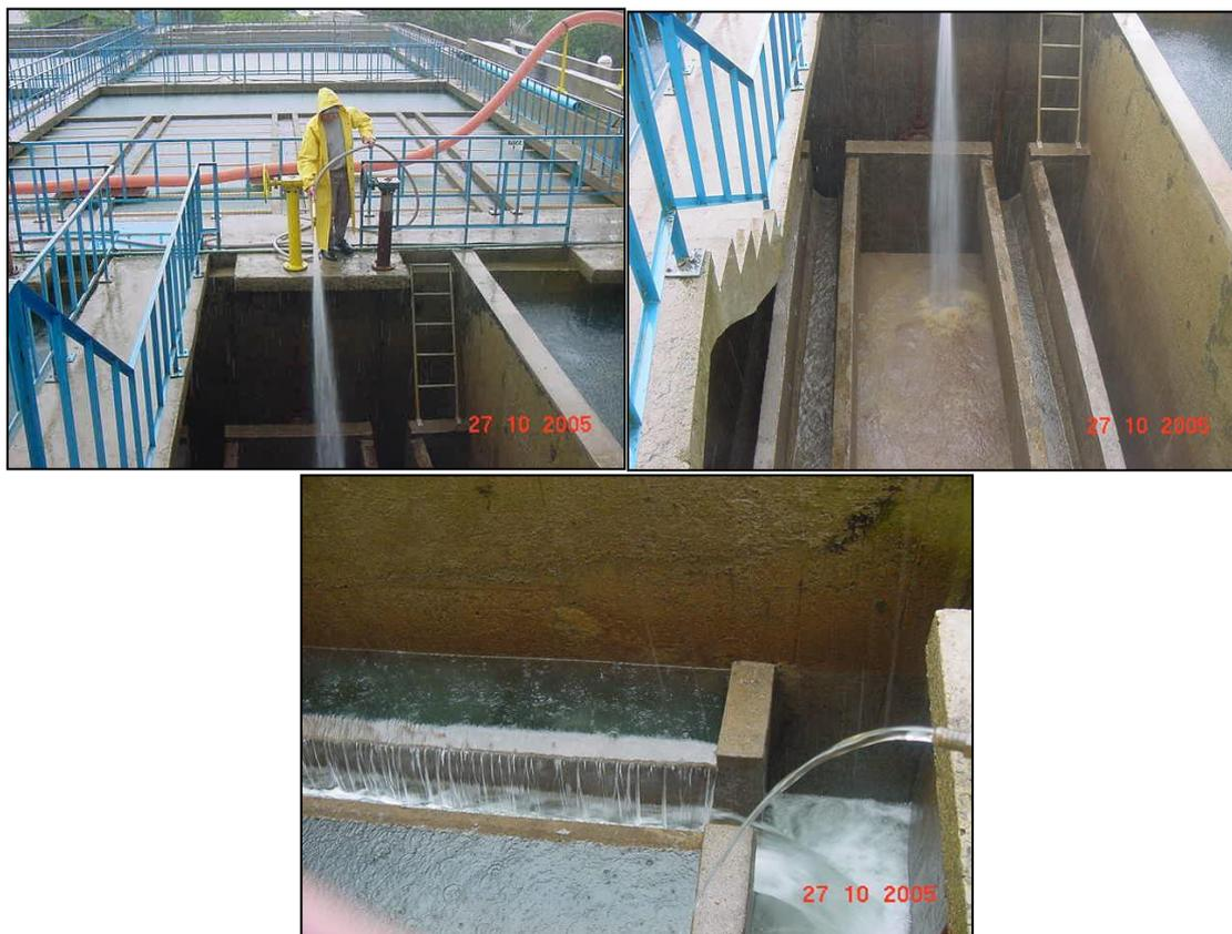
**Figura 4.3:** Processo de lavagem dos filtros.
