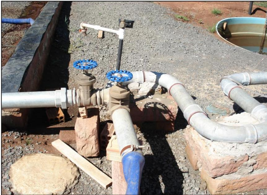
**Figura 3.7:** Câmara de manobra após a chicana (ziguezague)
