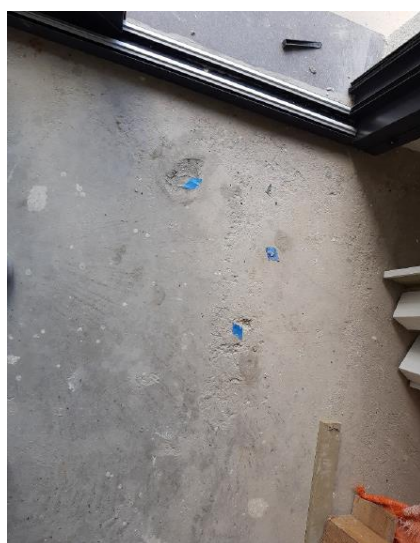
Figura 20 e 21: Defeitos na regularização da laje e execução do rejunte - marcações em azul
