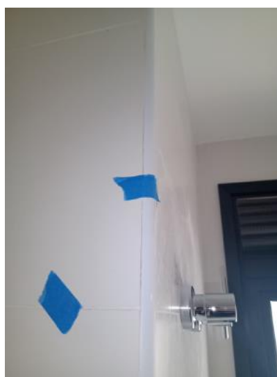
Figura 20 e 21: Defeitos na regularização da laje e execução do rejunte - marcações em azul
