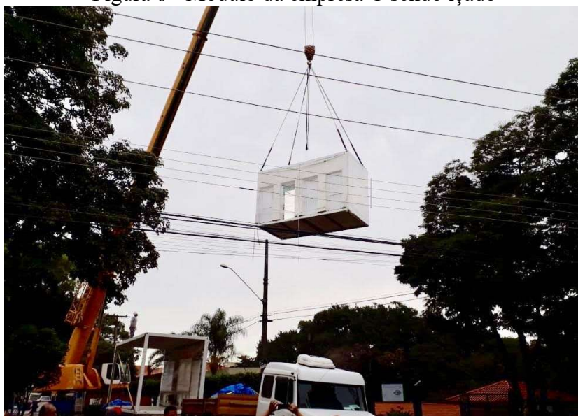
Figura 6 - Módulo da empresa C sendo içado
