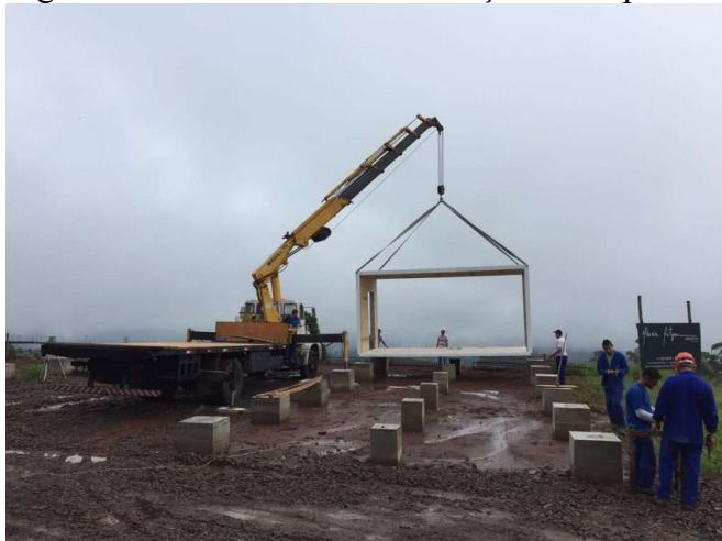
Figura 11 - Interface com a fundação da empresa C
