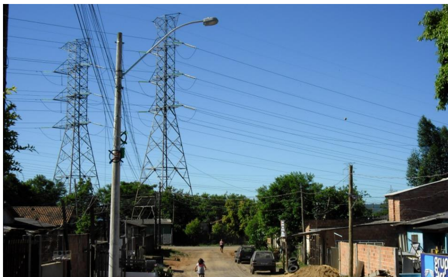
Figura 6 – Ocupação sob as Antenas de distribuição de energia elétrica
