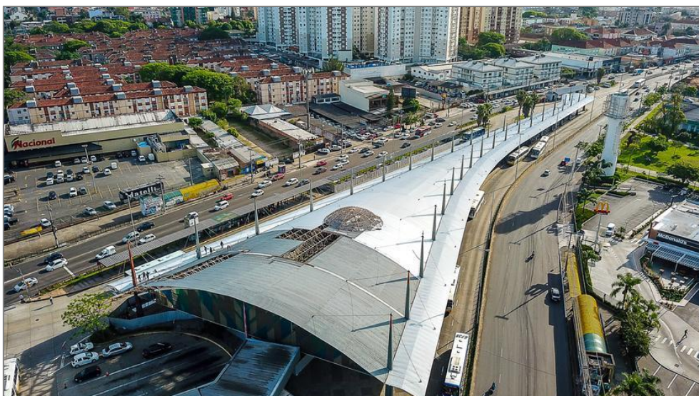
Figura 71 - Obras da cobertura do Terminal de passageiros Triângulo (Av. Assis Brasil, 4320). Fonte: https://bancoimagemens.portoalegre.rs.gov.br/imagem/37727
