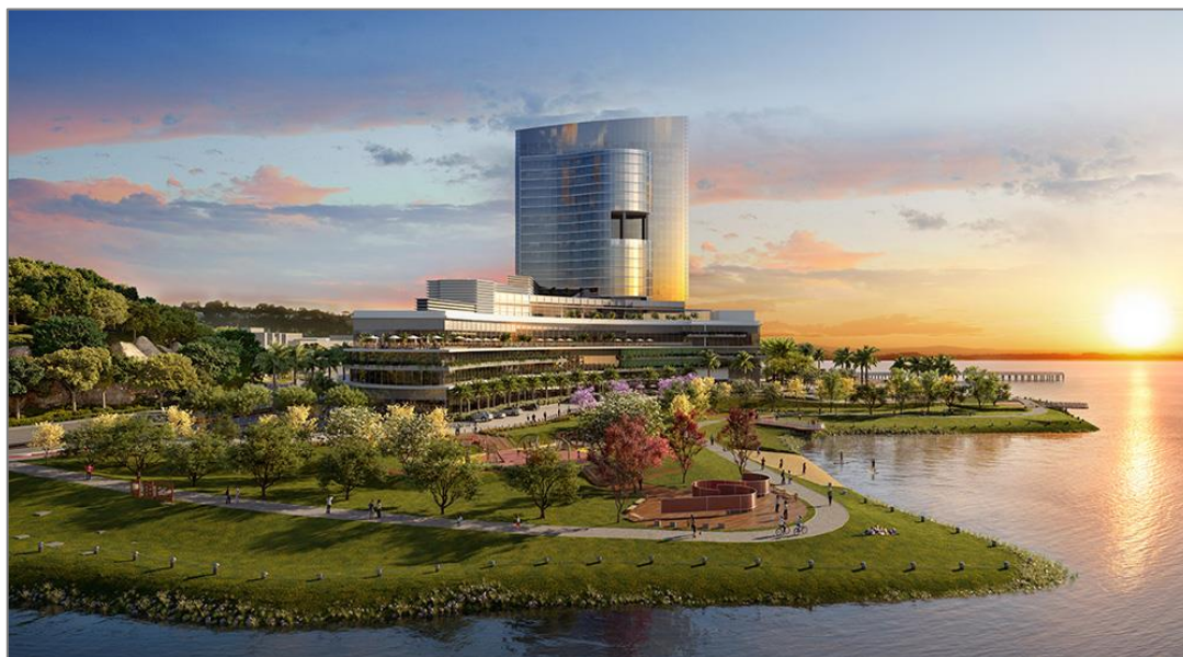
Figura 72 - Projeto Pontal com parque público em perspectiva (Av. Padre Cacique, 2893). Fonte: https://www.rbsdirect.com.br/imagesrc/35546217.jpg?w=1024&rv=2-10-05&safari
