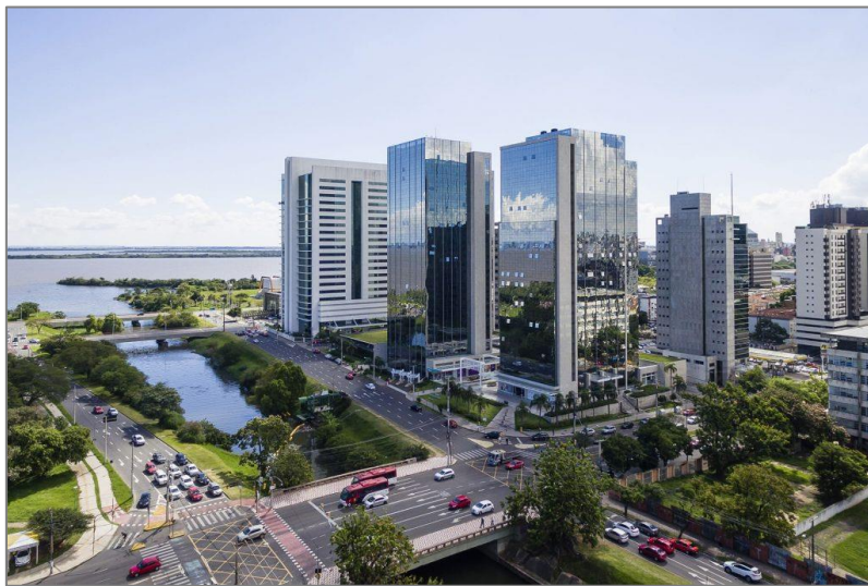
Figura 6 - Empreendimento Trend City Center (Av. Ipiranga, 40). Fonte: https://www.maiojama.com.br/empreendimentos/trend-city-center/#&qid=1&pid=1 .
