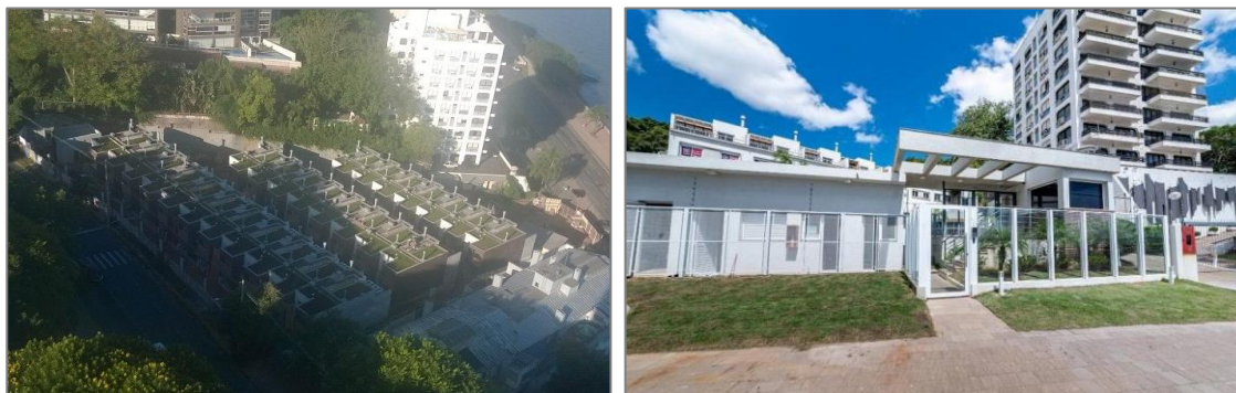
Figura 47 - Vista aérea e vista da fachada do empreendimento Encosta do Sol (Av. Pinheiro Borda 417 e Av. Padre Cacique, 1860). Fonte:
