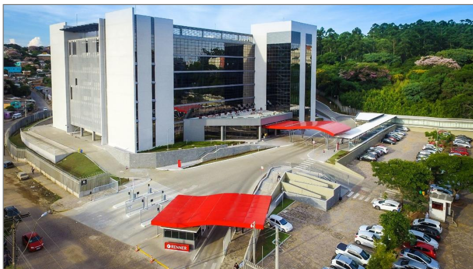
Figura 46 - Empreendimento Sede Lojas Renner (Rua Joaquim Porto Villanova, 401). Fonte: https://www.agenciapreview.com/a-nova-sede-administrativa-das-lojas-renner/
