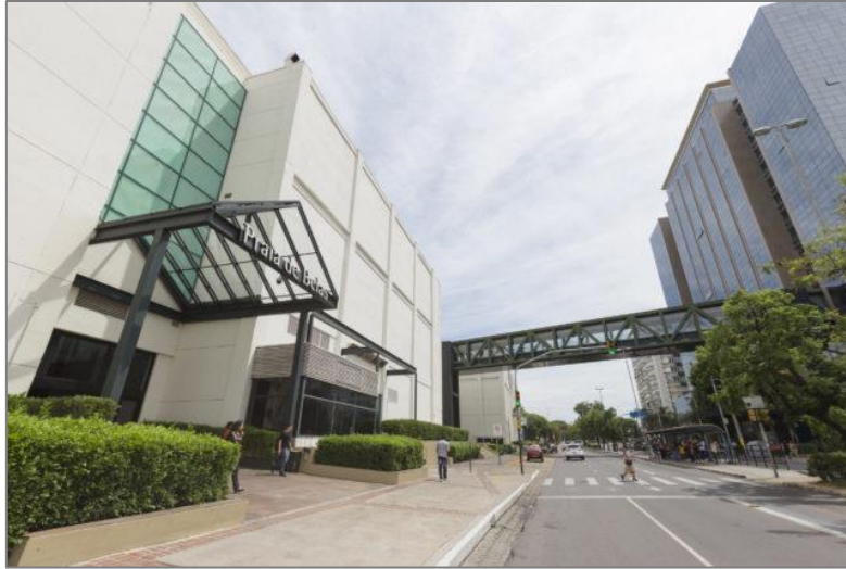
Figura 69 - Passarela de pedestres sobre a Av. Praia de Belas ligando o Shopping Center Praia de Belas ao seu edifício garagem. Fonte: https://www.jornaldocomercio.com/site/noticia.php?codn=107667
