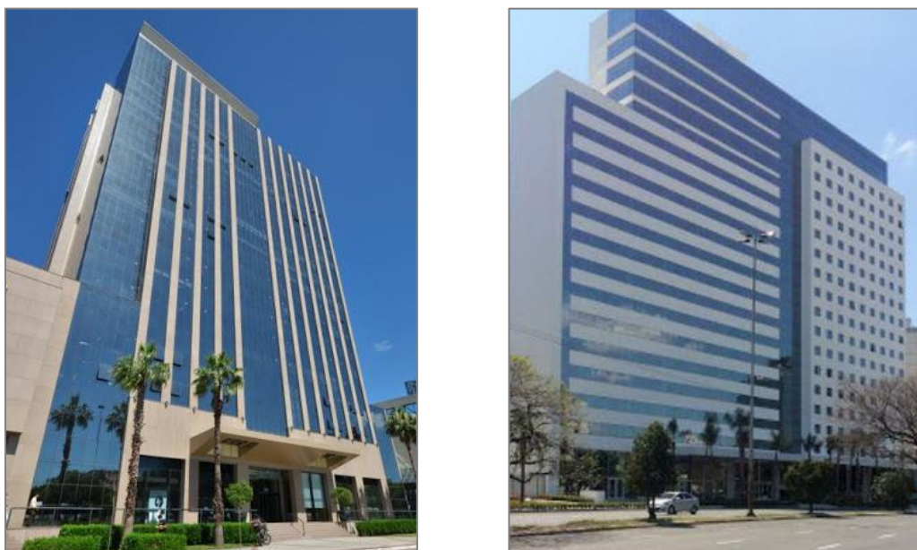
Figura 22 - Empreendimentos Praia de Belas Prime Office (Av. Borges de Medeiros, 2500) e Duo Concept (Av. Loureiro da Silva, 1940). Fonte: http://www.albertimoveis.com.br/sala-praia-de-belas-porto-alegre,400000346 e: https://webescritorios.com.br/edificio-comercial/duo-concept-corporate-6078 .
