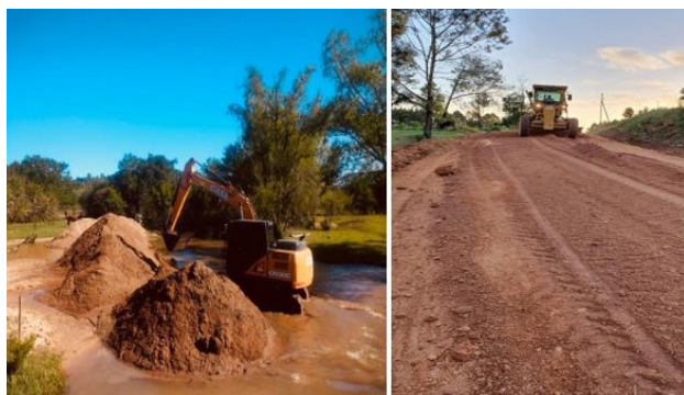
Figura 4.- Desassoreamento no município de Camaquã/RS, com uso benéfico do material. Fonte: Prefeitura Municipal de Camaquã, 2021.
