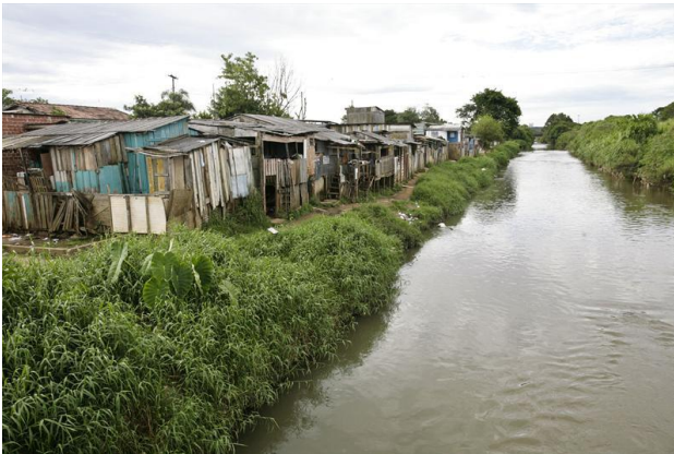
Figura 1.- Ocupação irregular às margens de recurso hídrico urbano, em Curitiba- PR/ Brasil. Fonte: Curitiba, 2022.
