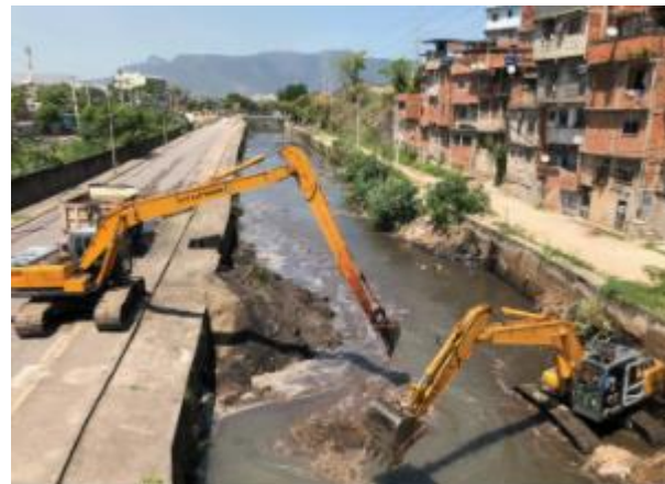
Figura 3.- Escavadeiras hidráulicas em operação dentro e fora de arroio canalizado. Fonte: LF Ambiental, 2021.
