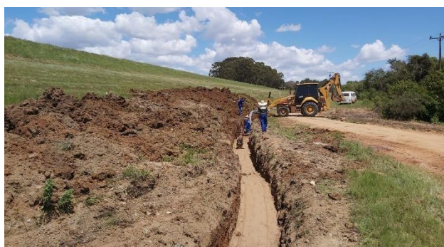
Figura 2. Aspecto da implantação da obra emergencial (trincheira drenante)
