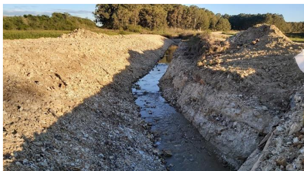
Figura 3. Canal extravasador provisório. Vista de montante
