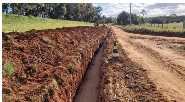
Figura 1. Aspecto da implantação da obra emergencial (trincheira drenante)
