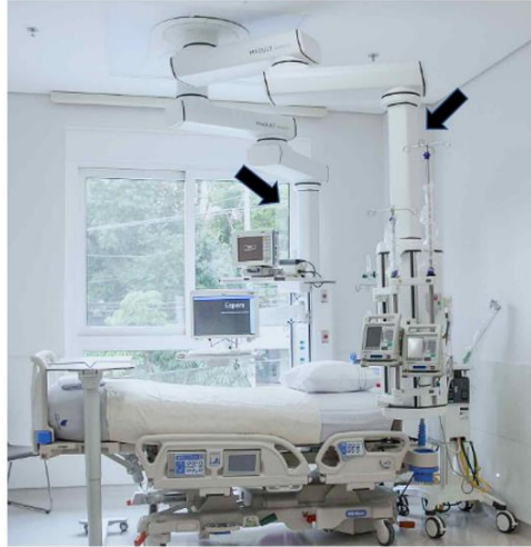
Figura 9: Estativas verticais articuladas.
