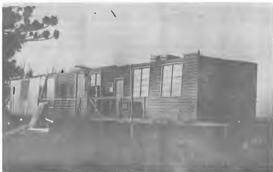
Figuras 8a, 8b – Acampamento para construção de barragens em Santiago
