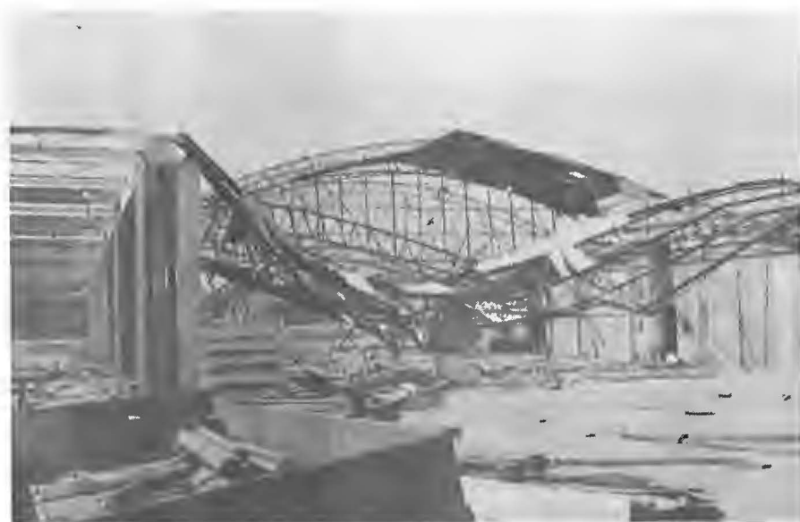
Figura 19 – Pavilhão industrial em construção em Guaíba, RS
