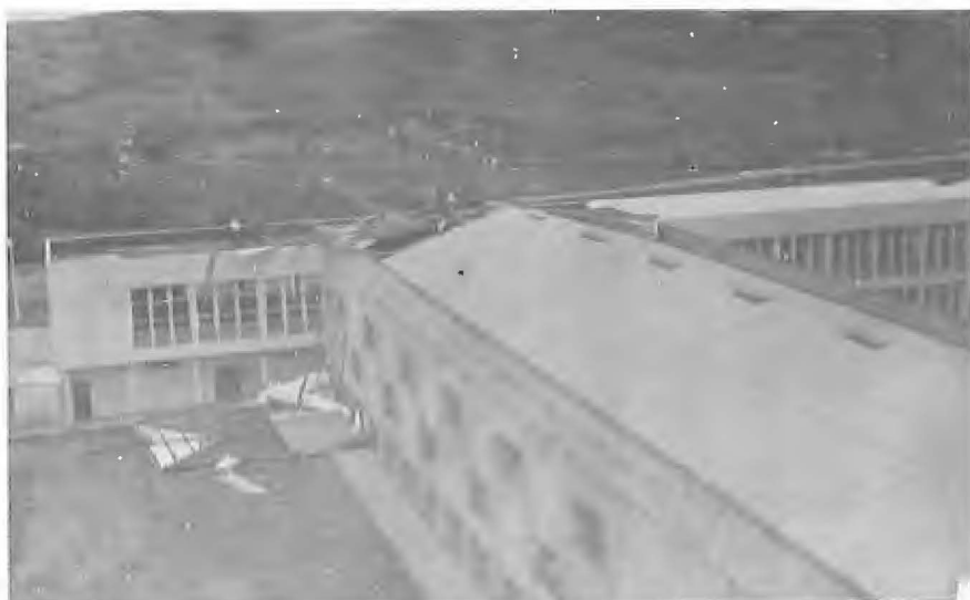
Figura 4 – Prédio nos arredores de Porto Alegre, RS
