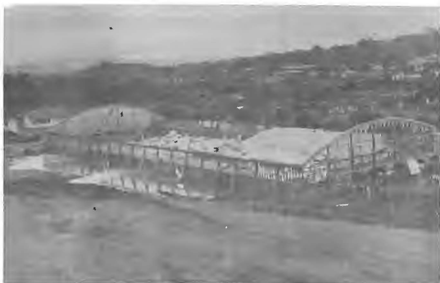
Figuras 5a, 5b – Pavilhão da FENAC em Novo Hamburgo, RS
