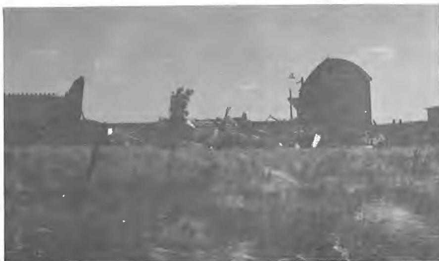
Figura 15 – Hangar em Carazinho, RS
