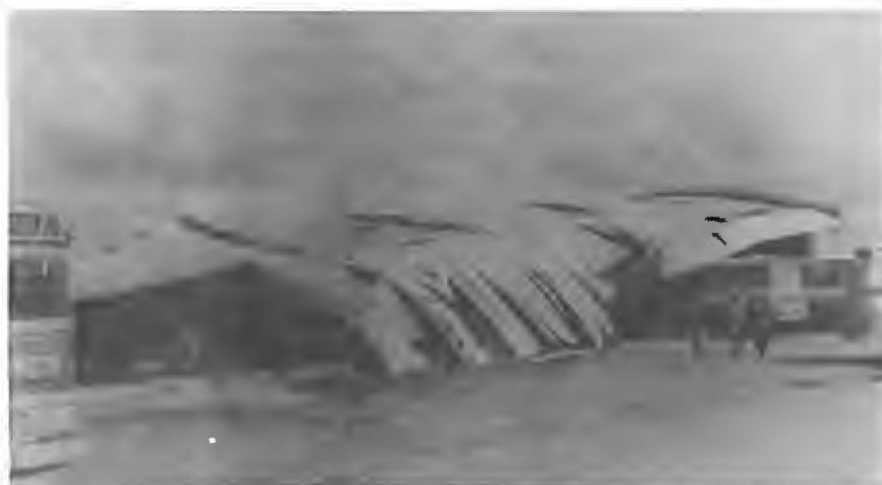
Figura 17 – Pavilhão do terminal de ônibus em Alvorada, RS
