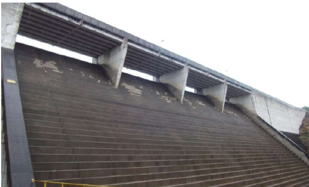
Figura 2-2. Visão da estrutura de dissipação de energia. (fonte: autor)
