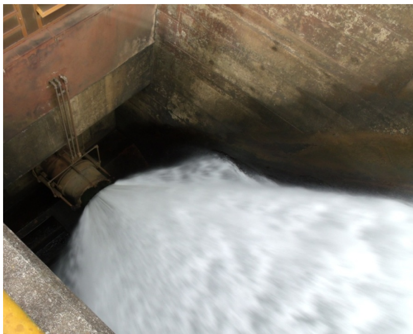
Figura 2-6. Válvula dispersora Rowell DN600. (fonte: autor)
