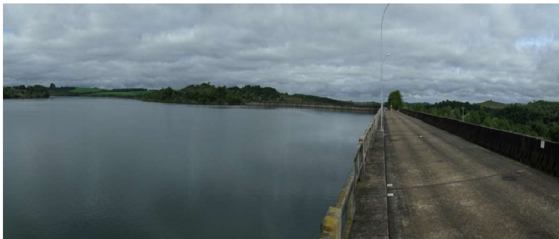
Figura 2-3. Vista parcial da barragem e do lago. (fonte: autor)
