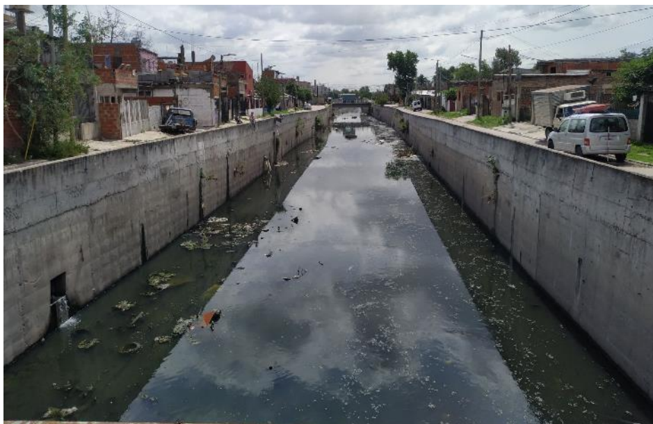
Figura 6. - EM16: sección canalizada de poca profundidad y difícil acceso.
