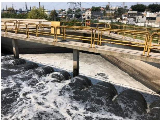
Figura 3.- Vista de montante de um dos vertedores em operação.
