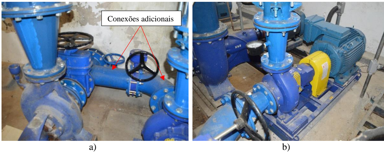
Figura 3.- a) Conexão na sucção da bomba hidráulica; b) Novo conjunto motobomba instalado.
