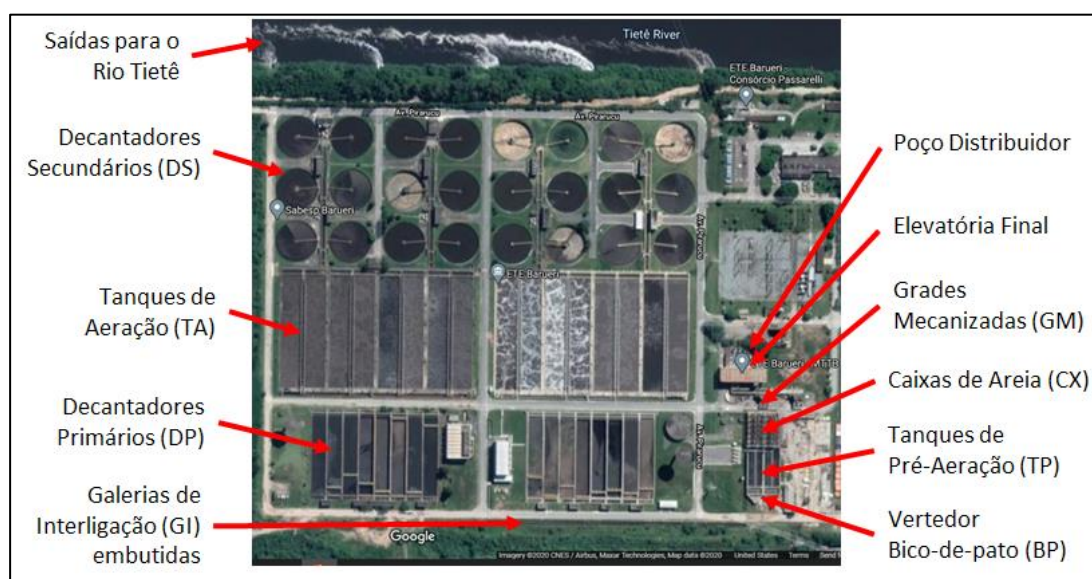
Figura 1.- Vista aérea da ETE Barueri.
