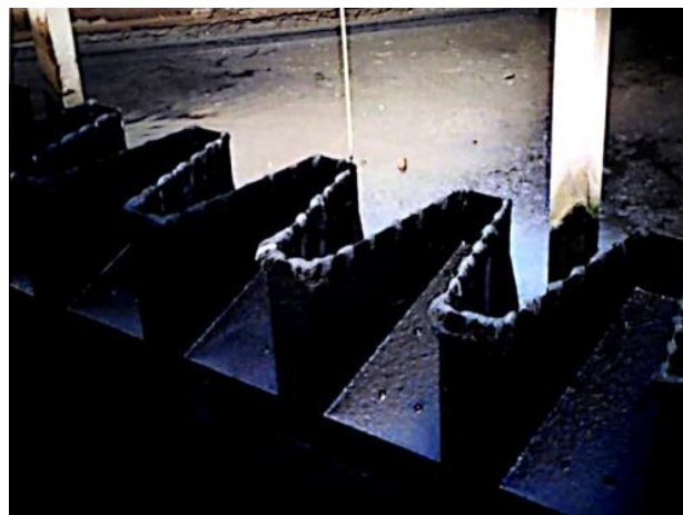
Figura 4.- Vista de montante de um dos vertedores ensecados.
