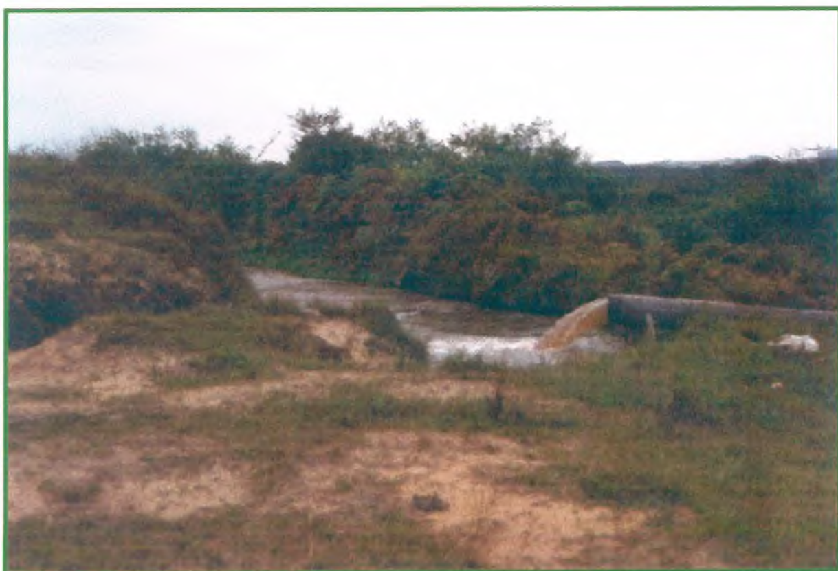
Fotografia 6.52 - Canais de irrigação com elevatórias para redistribuição, com novas tomadas d'água. Local: microbacia Ruínas
