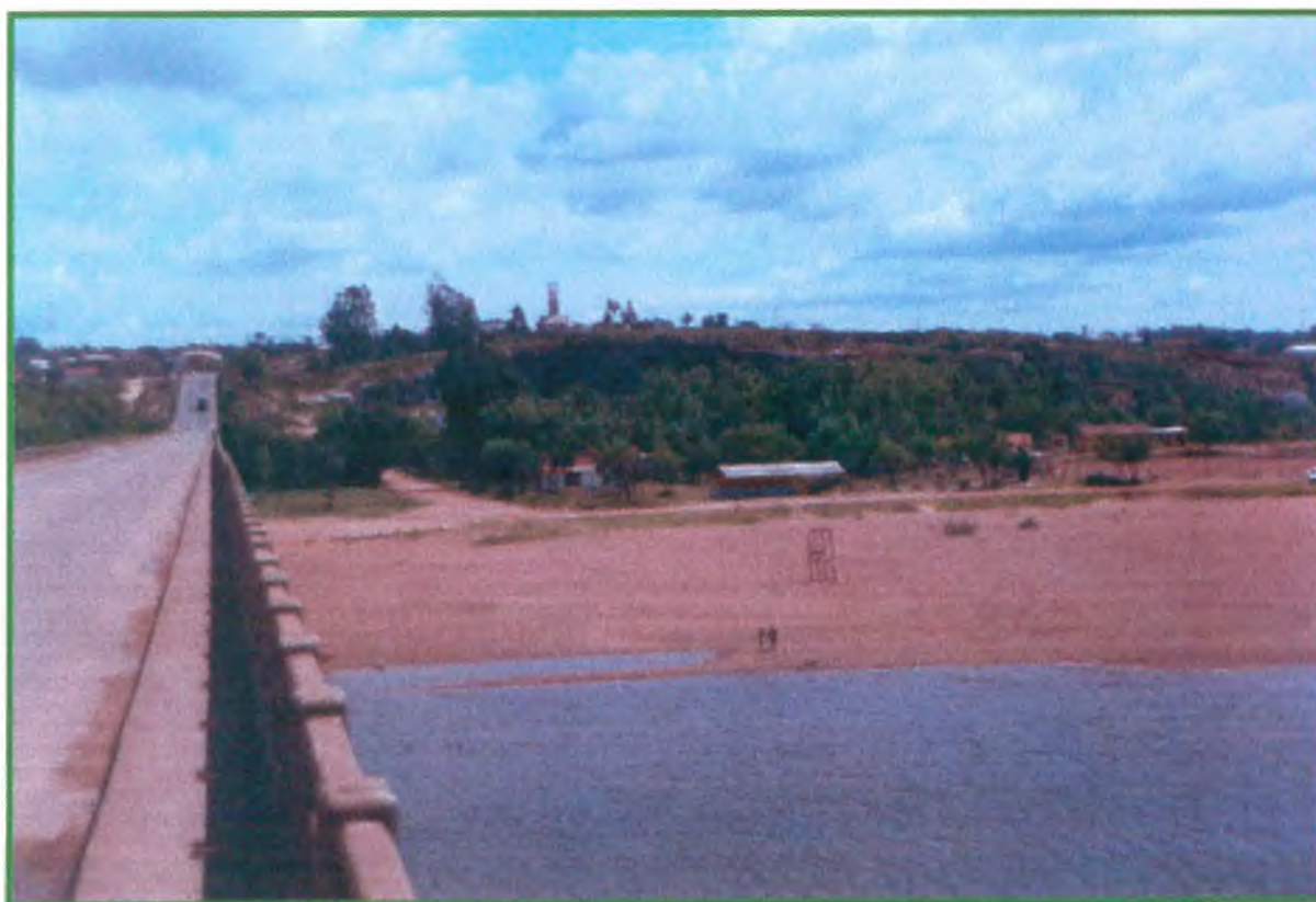
Fotografia 6.38 - Balneário de Cristal, em condições normais do rio Camaquã, Junho de 1999. Vista de S-N.
