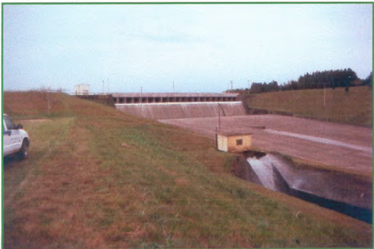
Fotografia 6.32 - Sistema de comportas para o vertedouro da barragem. Ao fundo, lago de represamento. Local: sub-bacia do arroio Duro/Sanga Formosa
