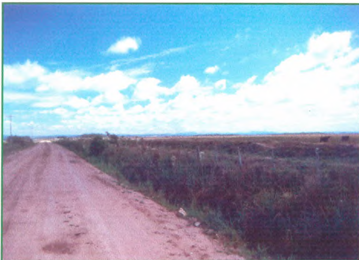
Fotografia 5.6 - Rodovia com revestimento solto de duas vias. Conexão de Pacheca com a Ilha de Santo Antônio. Local: microbacia da Ilha de Santo Antônio
