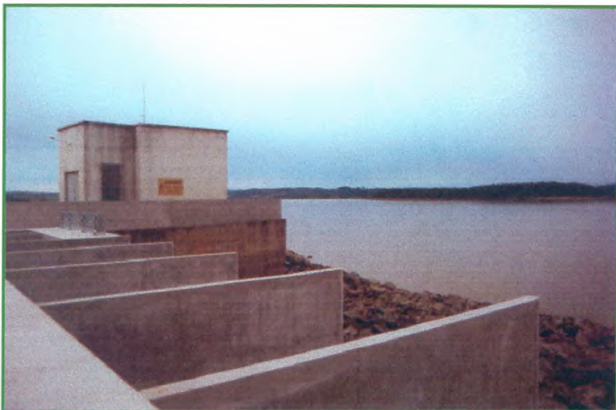
Fotografia 6.51 - Vista parcial do vertedouro da barragem do arroio Duro que alimenta os canais. Local: sub-bacia do arroio Duro/Sanga Formosa
