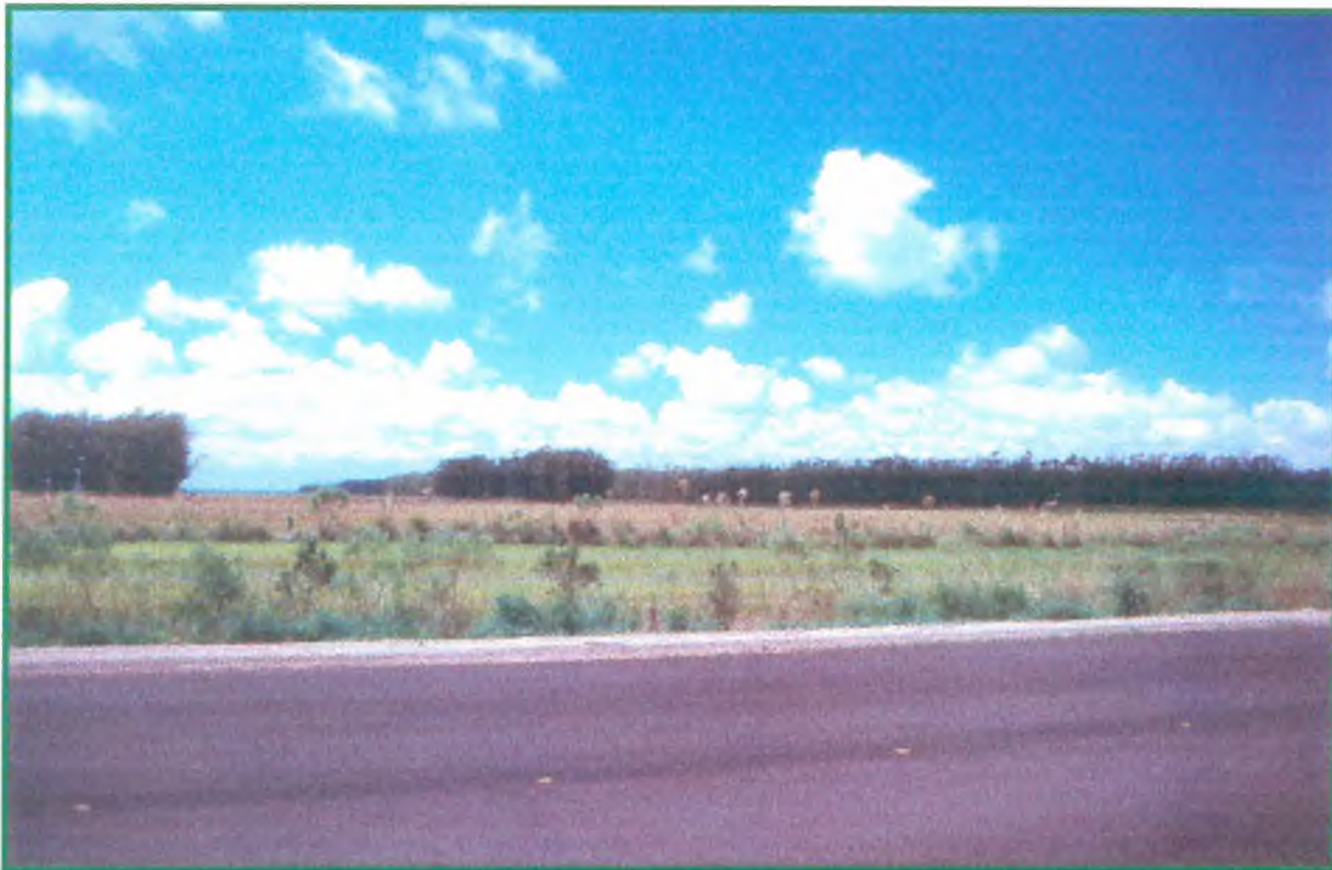
Fotografia 5.4 - Vista parcial da BR-116, rodovia com revestimento sólido de duas vias. Conexão de Camaquã com Cristal. Local: sub-bacia do arroio Duro/Sanga Formosa
