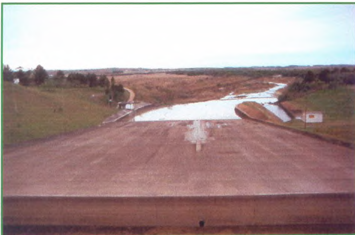
Fotografia 6.56 - Estação de coleta de águas sobre o arroio Duro/Sanga Formosa a jusante da barragem. Ao fundo, vista parcial da cidade de Camaquã. Local: sub-bacia do arroio Duro/Sanga Formosa
