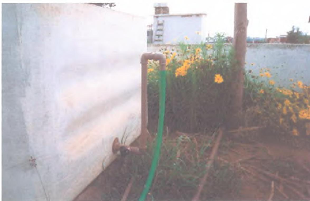
Figura 3.4 – Drenagem e torneira para coleta de amostras de banhados construídos estabelecidos.
