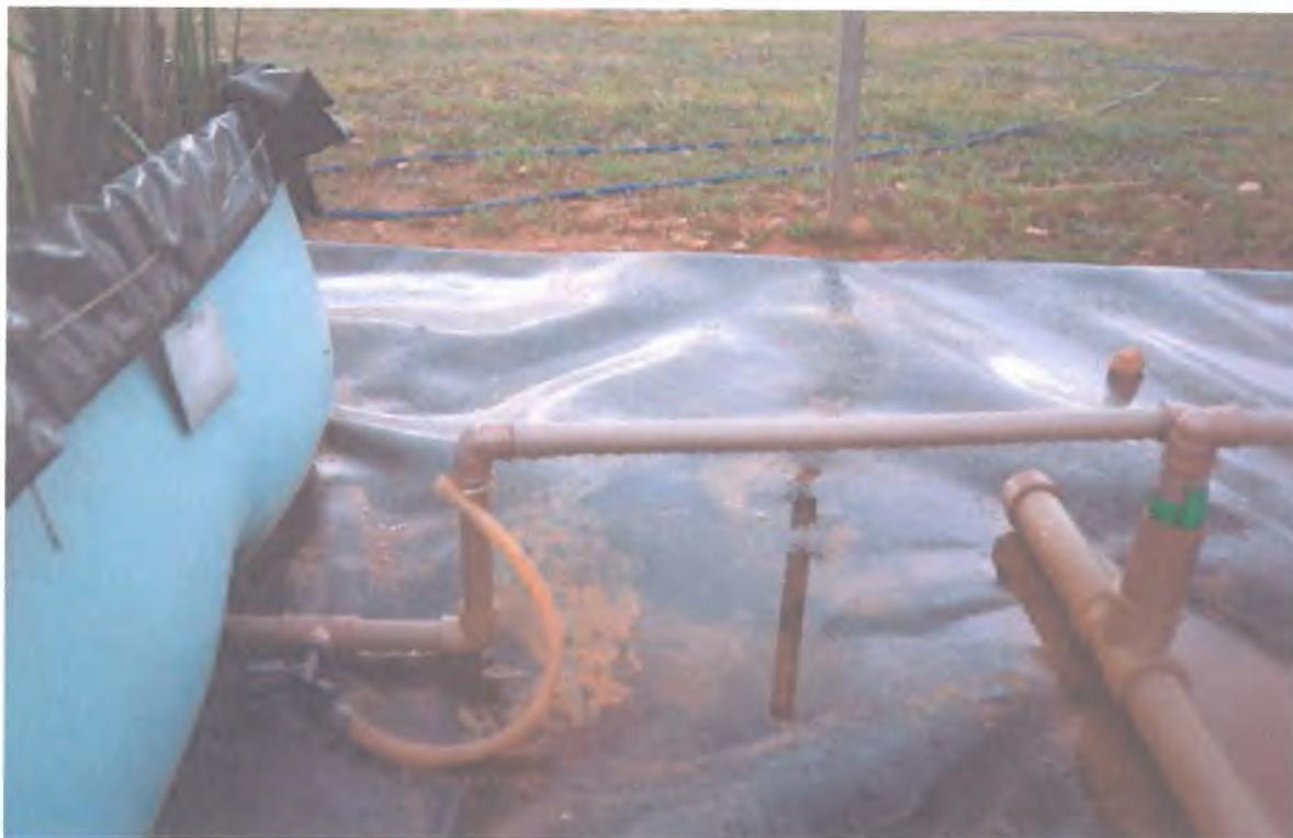
Figura 3.7 – Drenagem de banhados construídos em estabelecimento.
