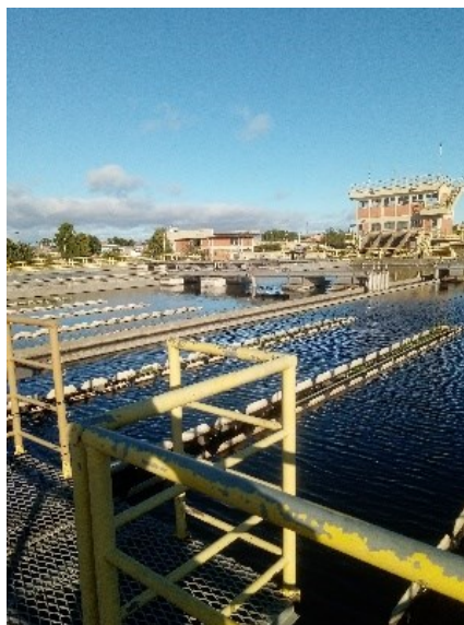
Figura 11 – ETE São João Navegantes
