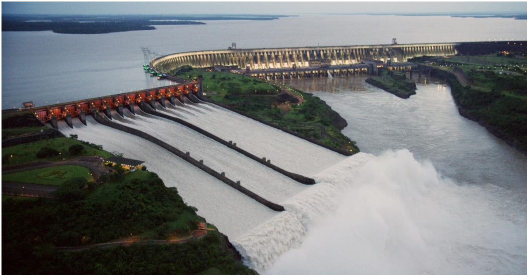
Figura 5 - Vertedouro salto esqui da Usina Hidrelétrica de Itaipu. Fonte: Itaipu Binacional.
