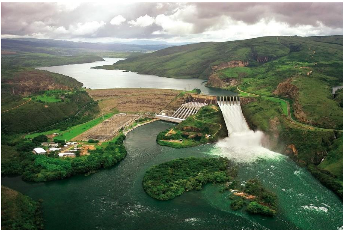
Figura 8 –UHE Furnas com o vertedouro em funcionamento. Fonte: Furnas Centrais Elétricas.
