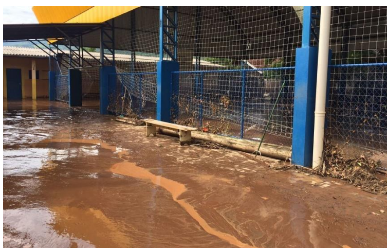
Figura 16. Registro fotográfico área inundada no evento. Fonte: Portal G1 5 .
