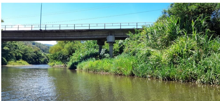
Figura 41. Registros fotográficos da seção PF2 - Margem Esquerda
