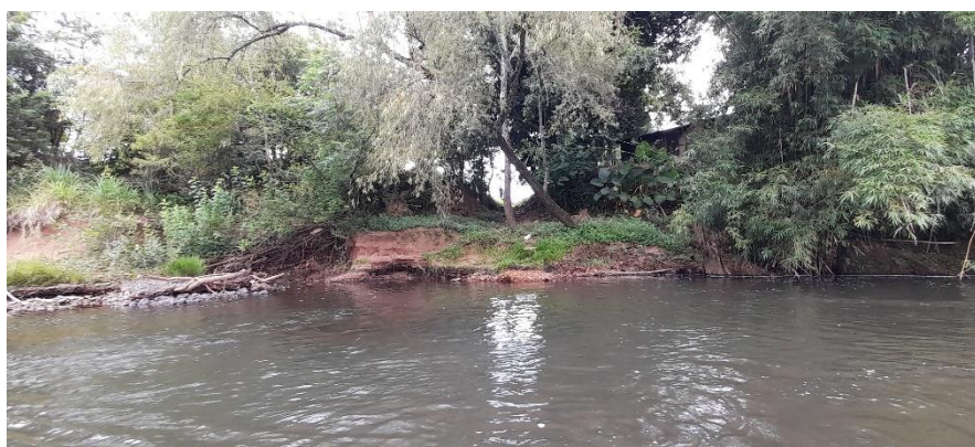
Figura 84. Registros fotográficos da seção PF14 - Margem Direita
