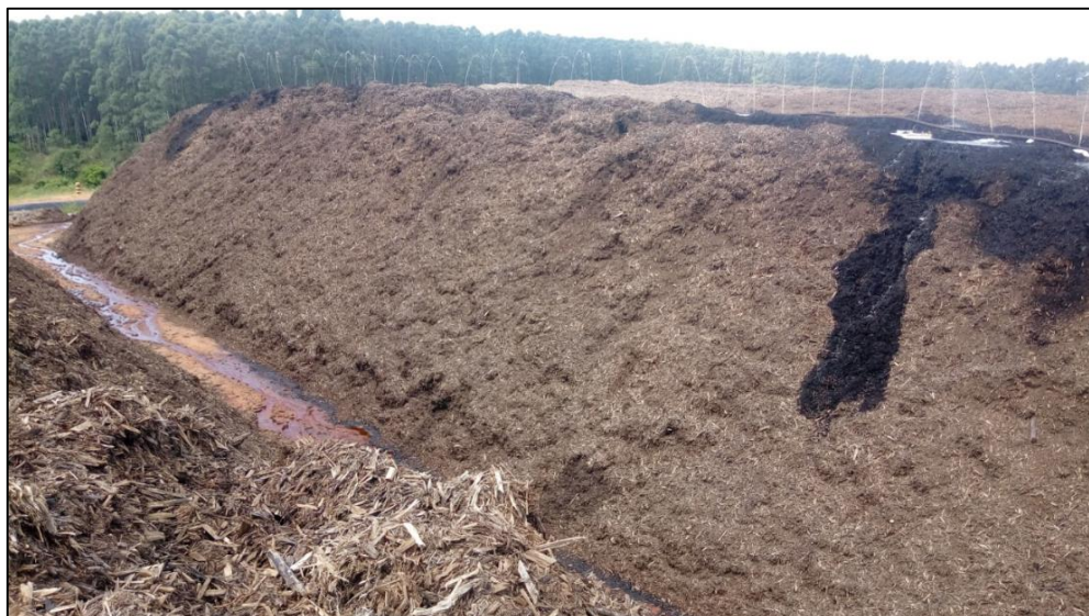
Figura 7 - Recirculação do percolado
