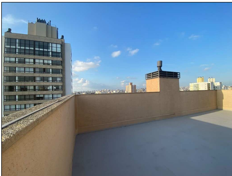
Figura 3 - Fotografia no pavimento Piso da Casa de Máquinas
