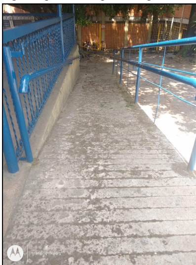
Figura 51: Fotografia produzida pelo Grupo 2 da rampa de acesso
