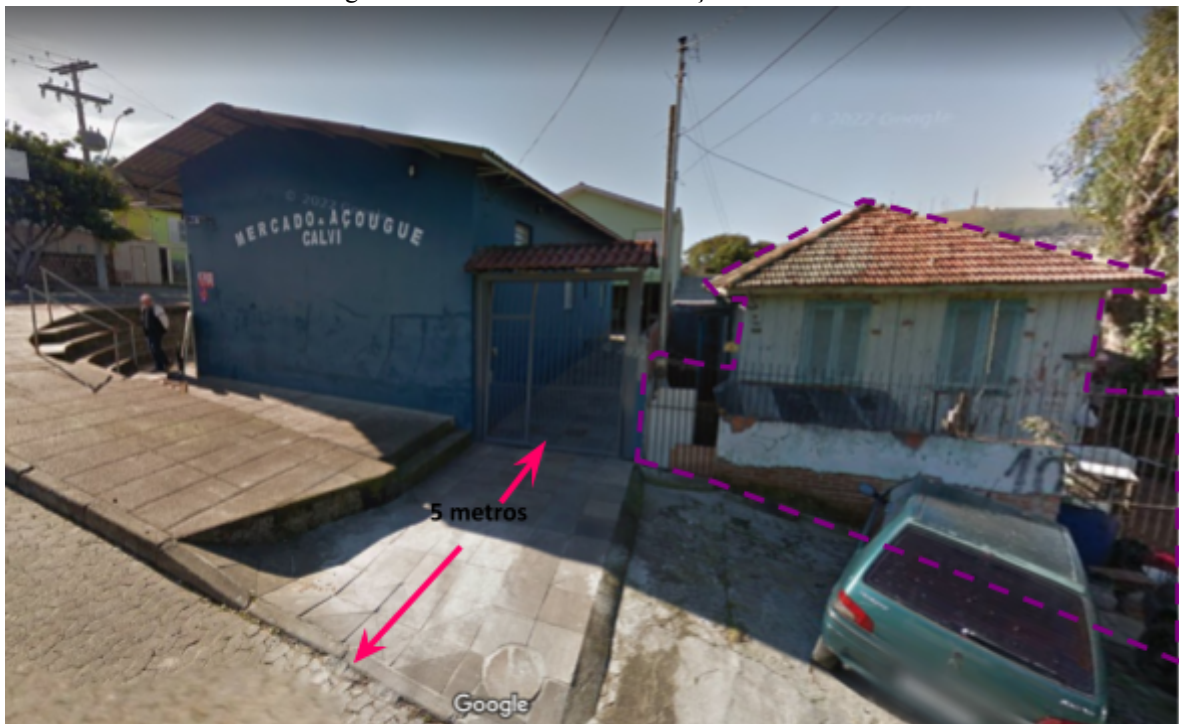
Figura 13 – Lado direito da edificação.
