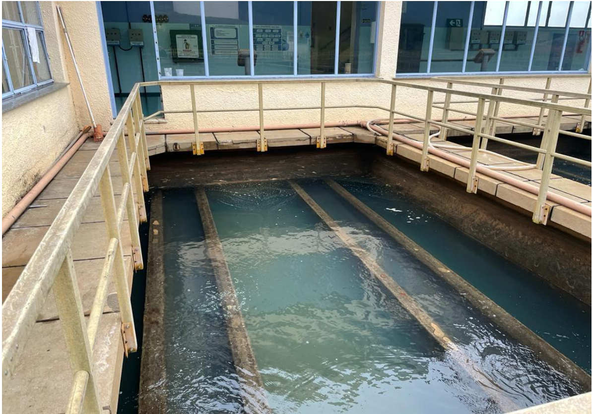
Figura 8 - Filtro rápido de fluxo descendente.
