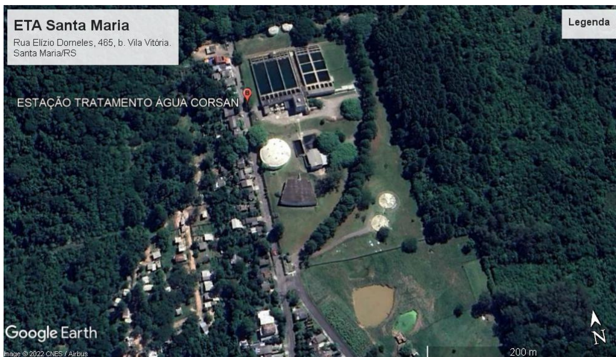
Figura 7 - Vista aérea da ETA Santa Maria
