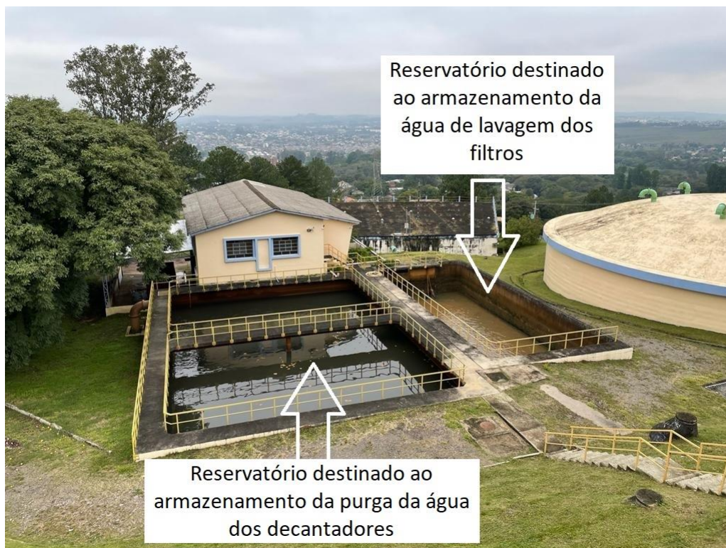
Figura 13 - Reservatório de armazenamento da água da lavagem dos filtros ETA – Santa Maria/RS
