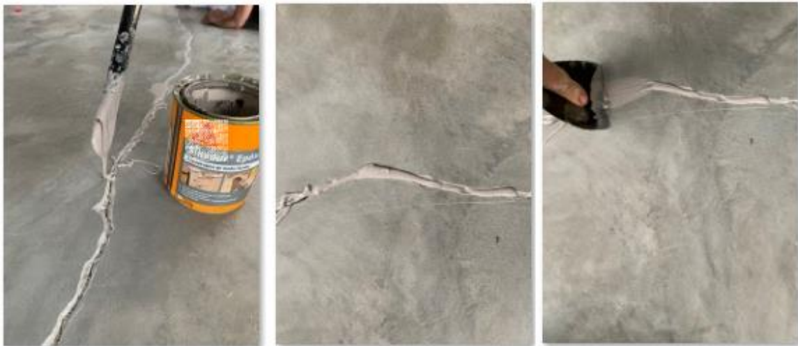
Figura 57 - Aplicação de adesivo epóxi de média fluidez para tratamento de fissuras
