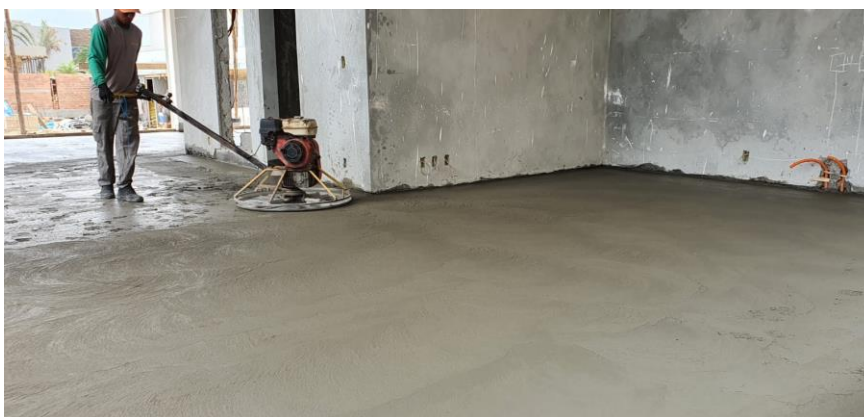
Figura 41 - Execução de piso de concreto polido com disco de flotação
