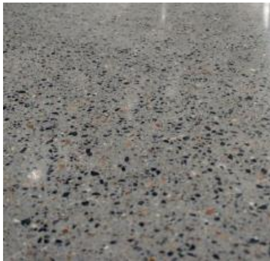
Figura 52 - Piso de concreto lixado e polido
