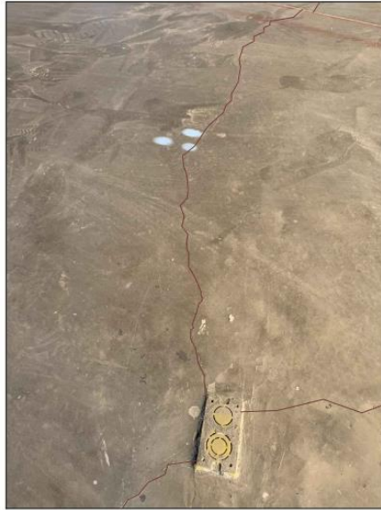
Figura 48 - Fissuras saindo de ponto de tomada no piso
