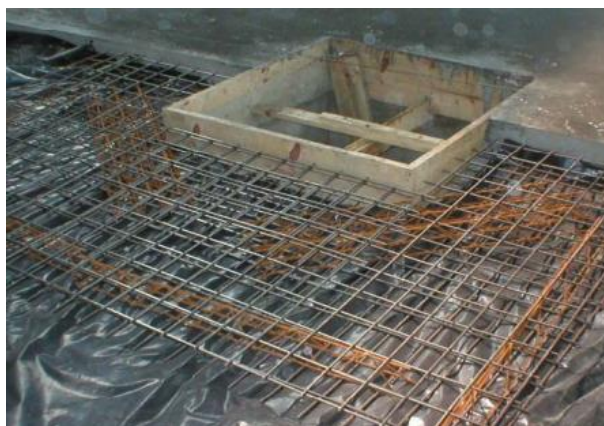
Figura 50 - Armadura de combate a retração
