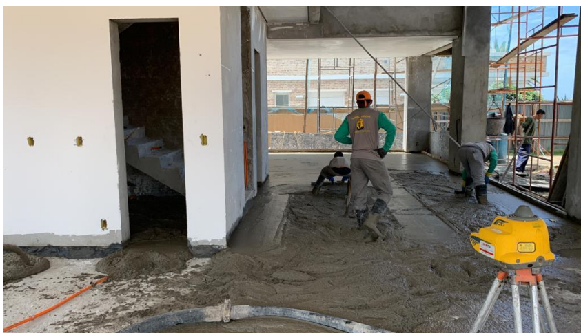
Figura 38 - Execução de piso de concreto polido
