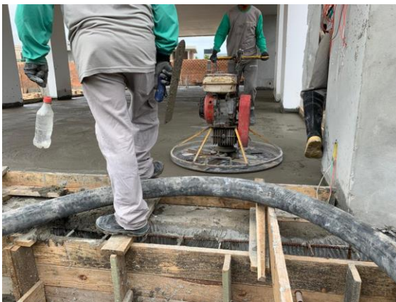
Figura 40 - Execução de piso de concreto polido com disco de flotação
