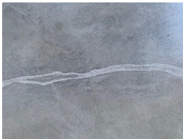
Figura 58 – Fissura tratada com adesivo epóxi endurecido
