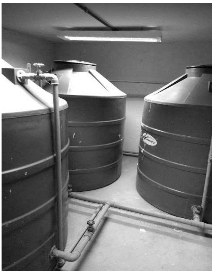
Figura 19 – Reservatórios superiores
