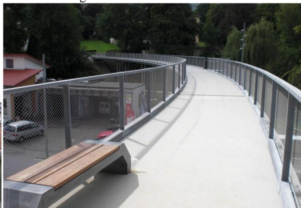
Figura 4 – Passarela de Albstadt
