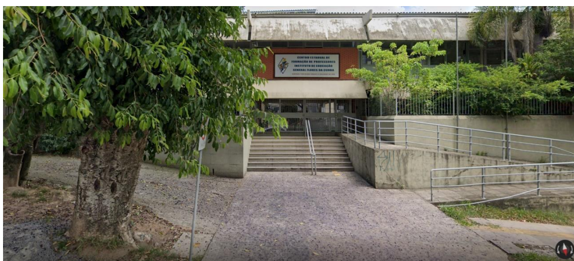
Figura 3 13 : Fachada da sede temporária do Instituto de Educação General Flores da Cunha.
