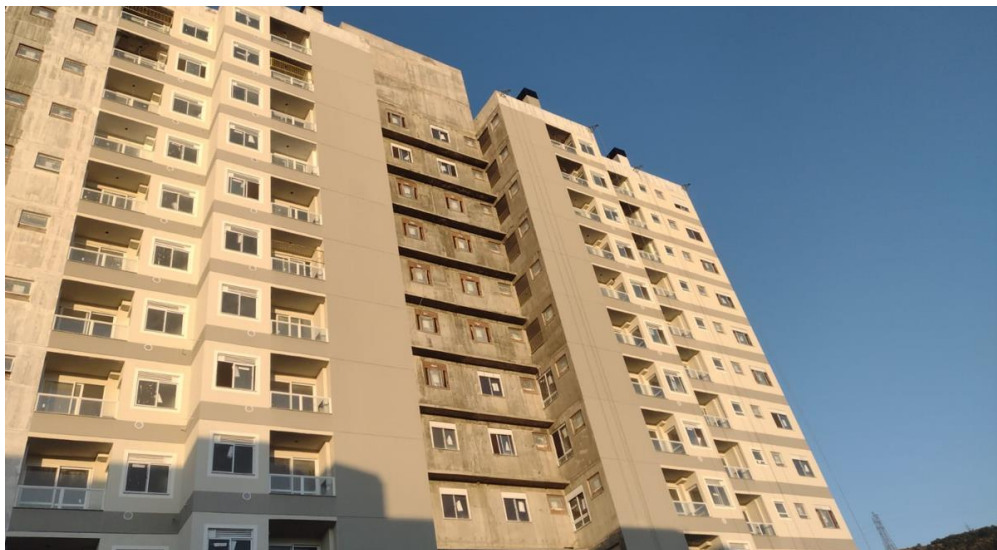
Figura 17 – Diversas etapas em uma mesma fachada
