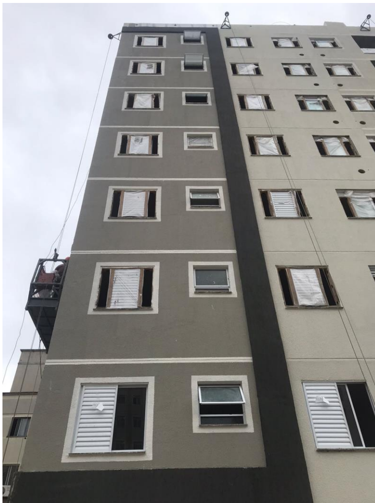
Figura 16 – Pano de fachada acabado na obra 1
