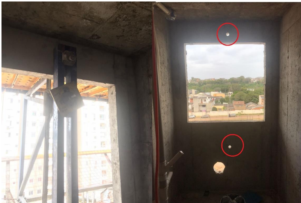
Figura 9 – Vãos resultantes da ancoragem do andaime
