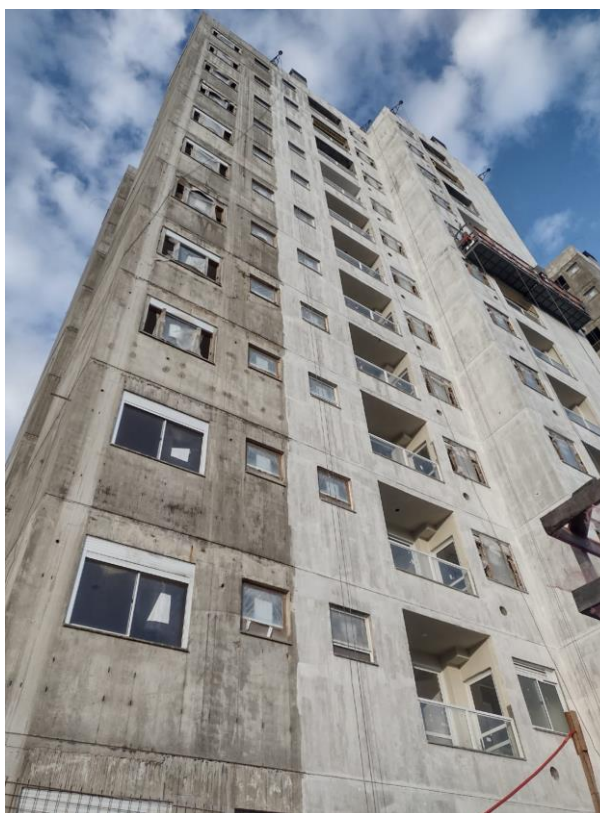
Figura 14 – Aplicação do selador elastomérico
