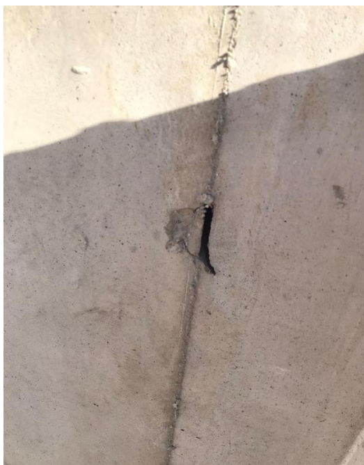
Figura 8 – Vão deixado pela retirada das faquetas da forma
