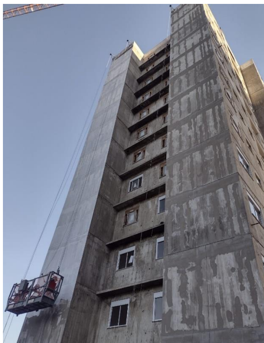
Figura 10 – À direita, fachada regularizada com argamassa colante
