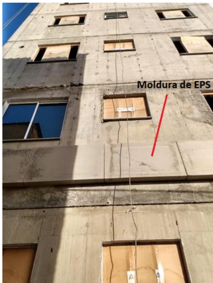
Figura 12 – Moldura de EPS instalada no sentido horizontal
