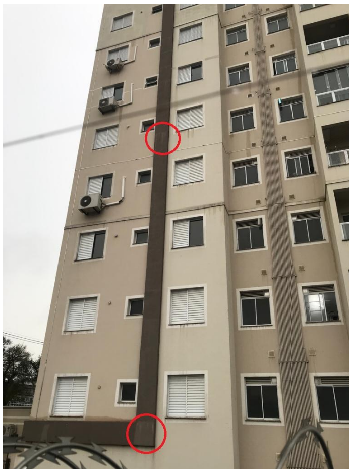
Figura 27 – Provável efluorescência observada na obra B
