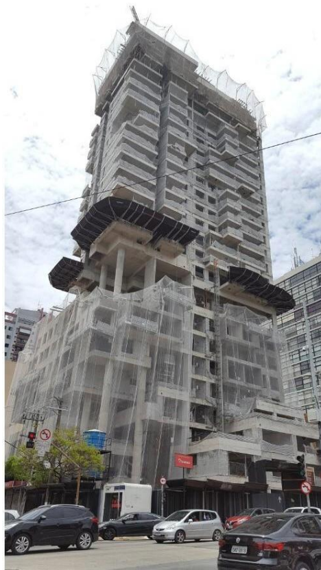
Figura 22 – Obra POD em execução
