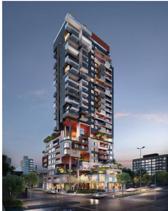
Figura 20 – Obra POD em São Paulo
