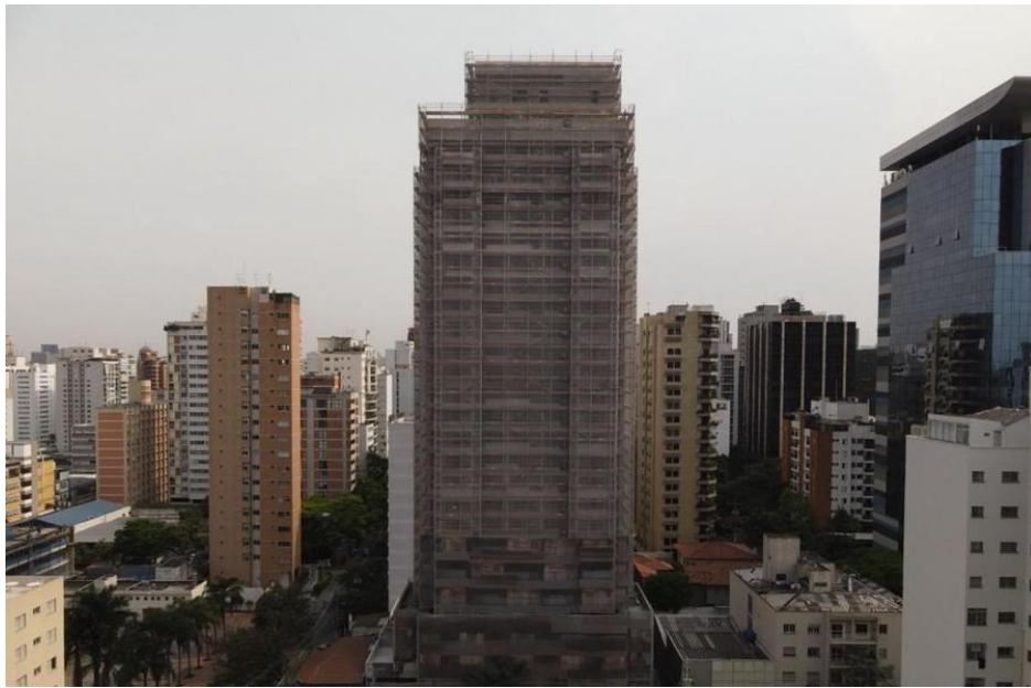
Figura 33 – Envelopamento completo do andaime
