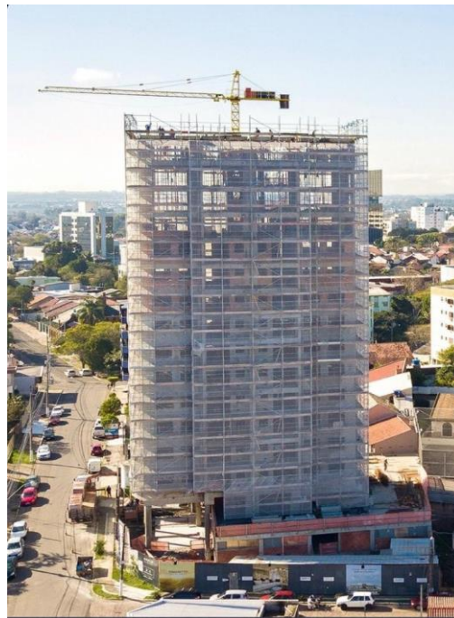
Figura 18 – Obra Upper em Gravataí - RS
