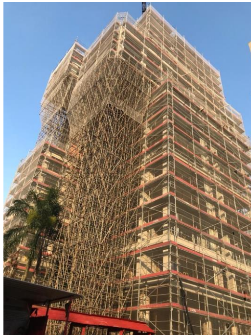
Figura 23 – Obra ON Melo Alves em execução
