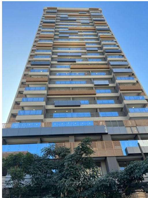
Figura 31 – Fase de finalização do empreendimento
