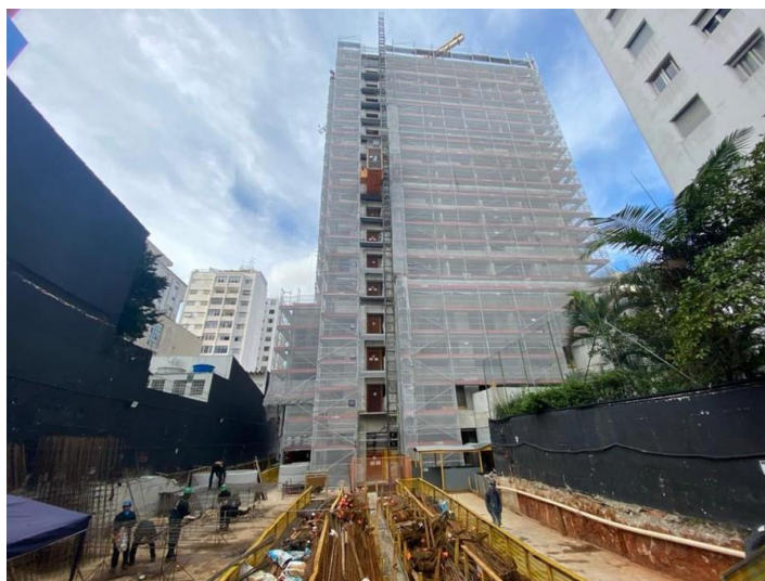
Figura 32 – Canteiro de obra
