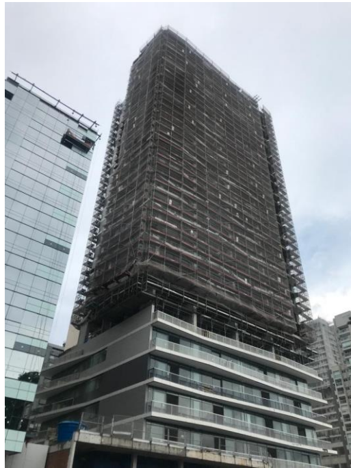
Figura 19 – Obra JFL em São Paulo
