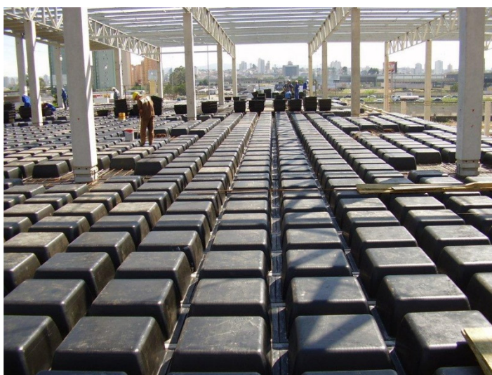
Figura 32 - Montagem das nervuras
