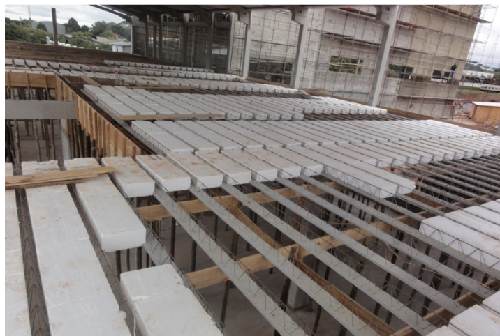
Figura 36 - Execução de laje treliçada
