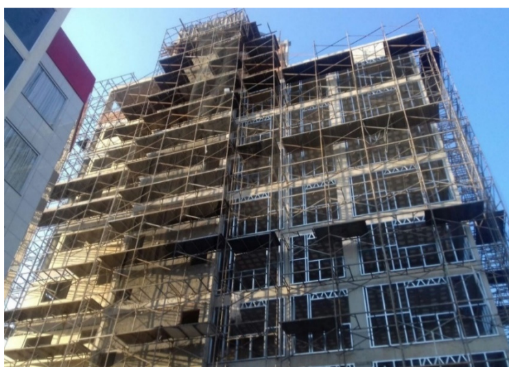
Figura 26 - Execução das vedações externas em LSF
