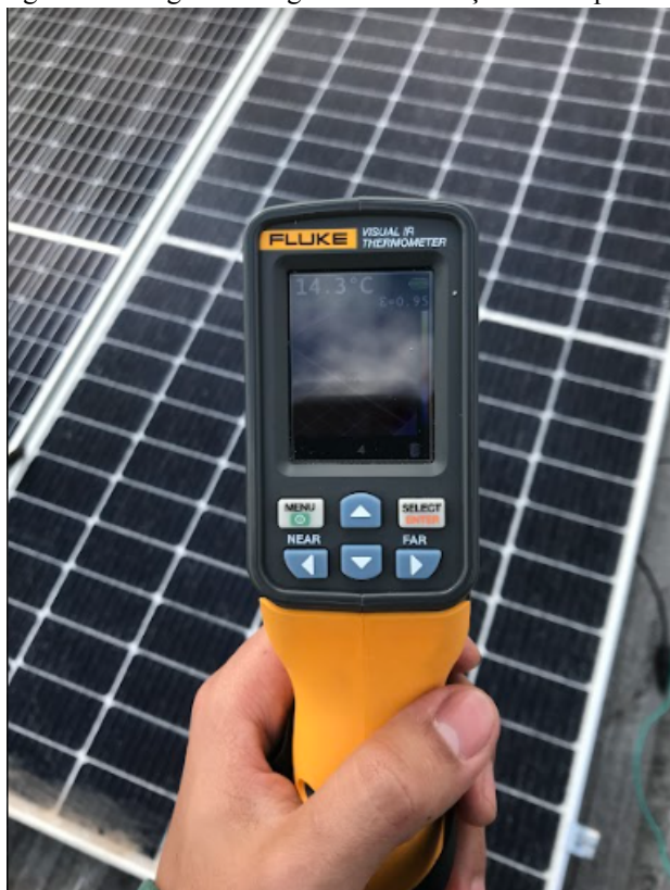
Figura 14 - Registro fotográfico da medição de temperatura
