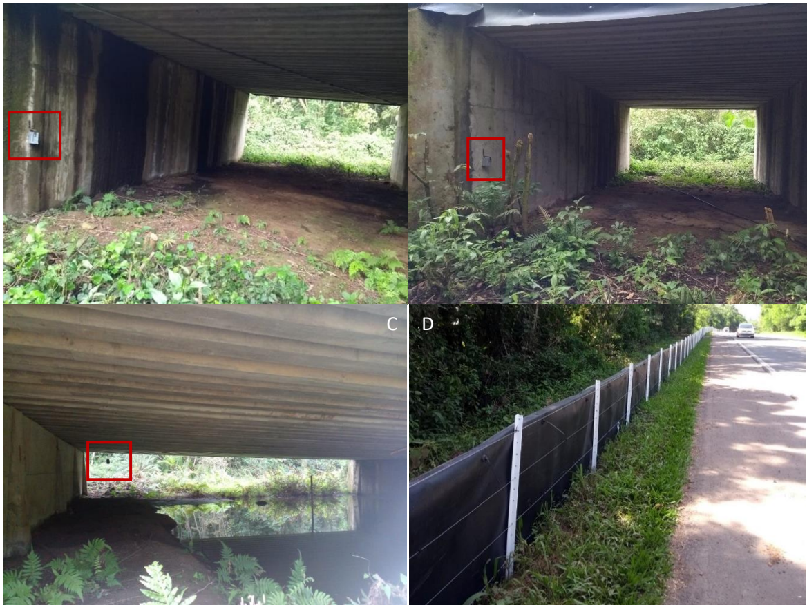
Figura 3. Passagens de Fauna do tipo pontilhão identificadas como “A” PF01; “B” PF02 e “C” PF03 monitoradas na área da RBMP, Rota do Sol, município de Itati, Rio Grande do Sul. Em destaque no quadrado vermelho está à disposição das armadilhas fotográficas. Em “D” a cerca direcionadora instalada.
