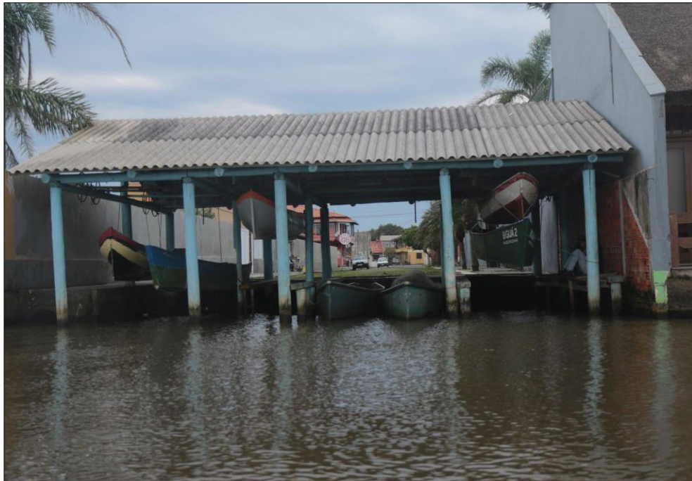
Figura 12 – Sarilhos na margem urbanizada no município de Imbé. Foto: Ignácio Moreno.
