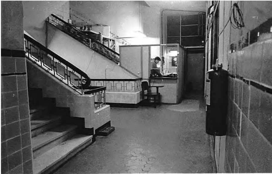
Saguão no fundo do corredor do primeiro andar, anos 1970.
