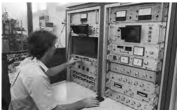
Engenheiro Agostinho Antônio Bulla operando o sistema de controle eletrônico do implantador.
